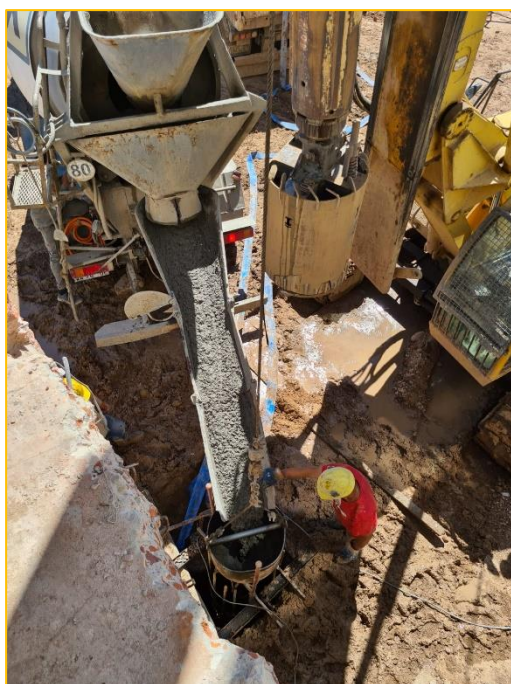
Fotografías 14 y 15. Proceso de hormigonado y bombeo de bentonita.
