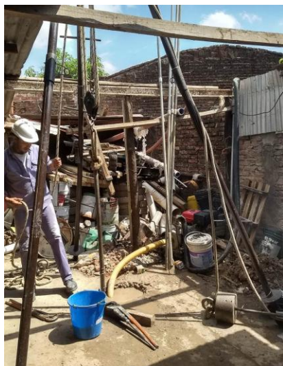
Fotografía N°3: Ejecución sondeo N°3
