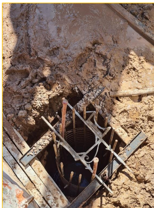
Fotografía 10. Armadura posicionada.
