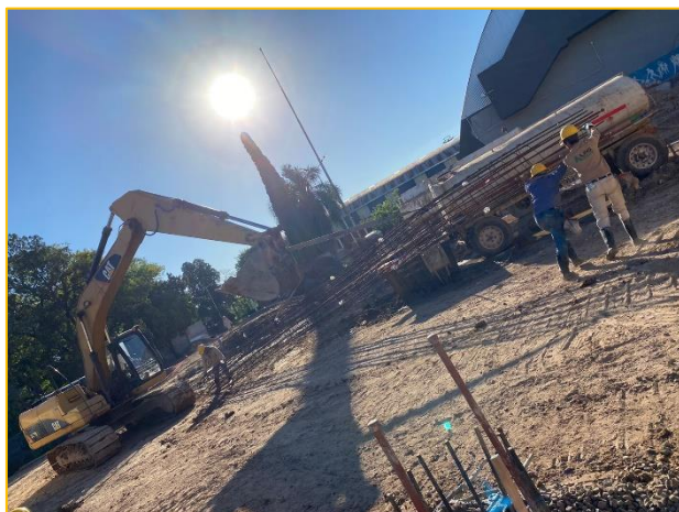
Fotografías 7 y 8. Izado y descenso de armadura.
