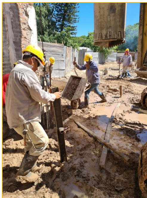
Fotografía 11. Piedra basáltica para celda de precarga.
