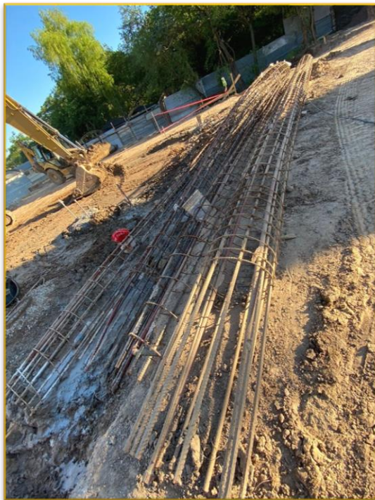
Fotografías 1 y 2. Armadura acopiada y volquete para bentonita.
