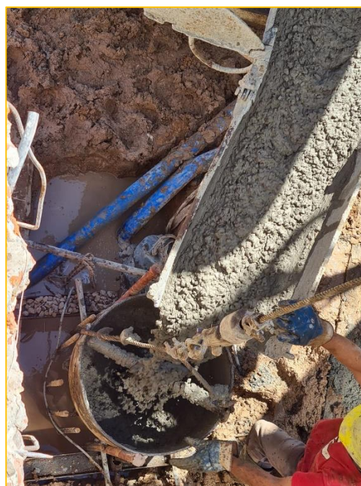
Fotografías 14 y 15. Proceso de hormigonado y bombeo de bentonita.
