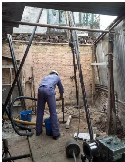
Fotografía N°1: Ejecución sondeo N°1
