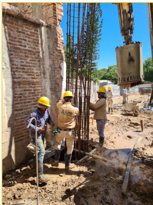
Fotografía 9. Empalme de armadura.
