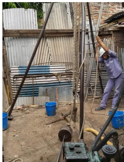
Fotografía N°2: Ejecución sondeo N°2
