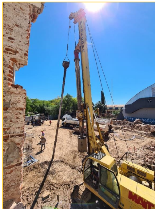
Fotografías 12 y 13. Izado y descenso de tubo tremi.
