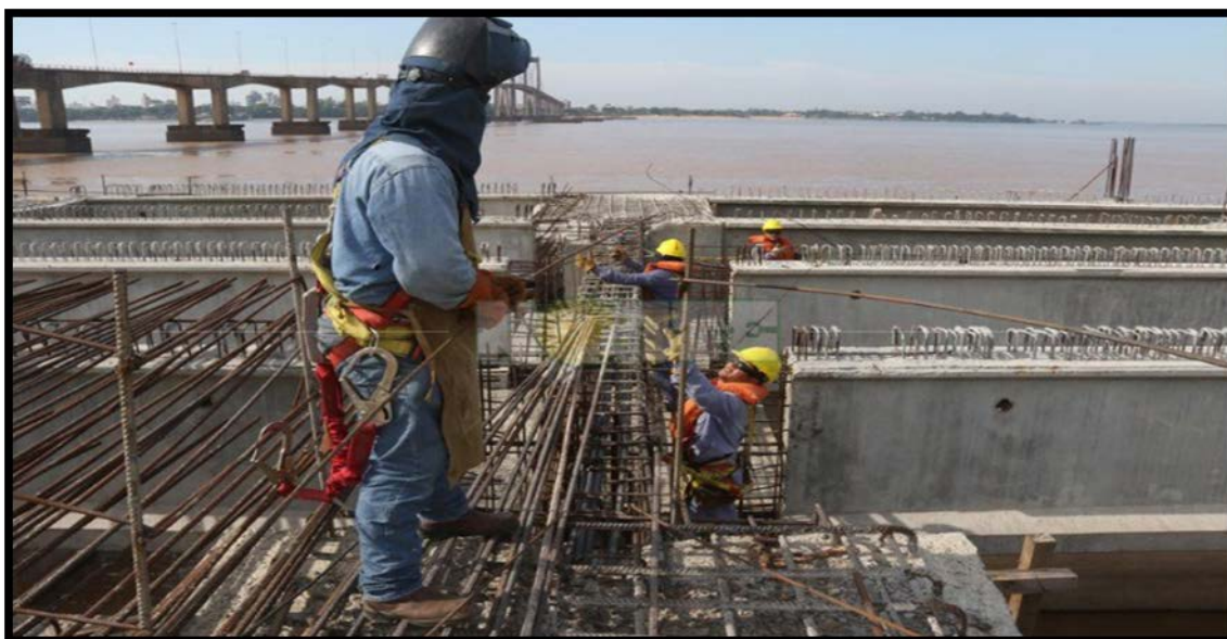
Imagen 2.2.3 - Construcción de la toma para acueducto para interior. (Imagen de Rovella Carranza)
