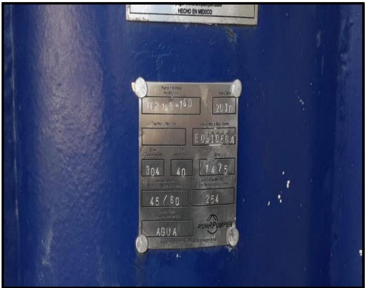
Imagen 2.2.10 - Detalles de Potencia y Caudal de la Bomba.
