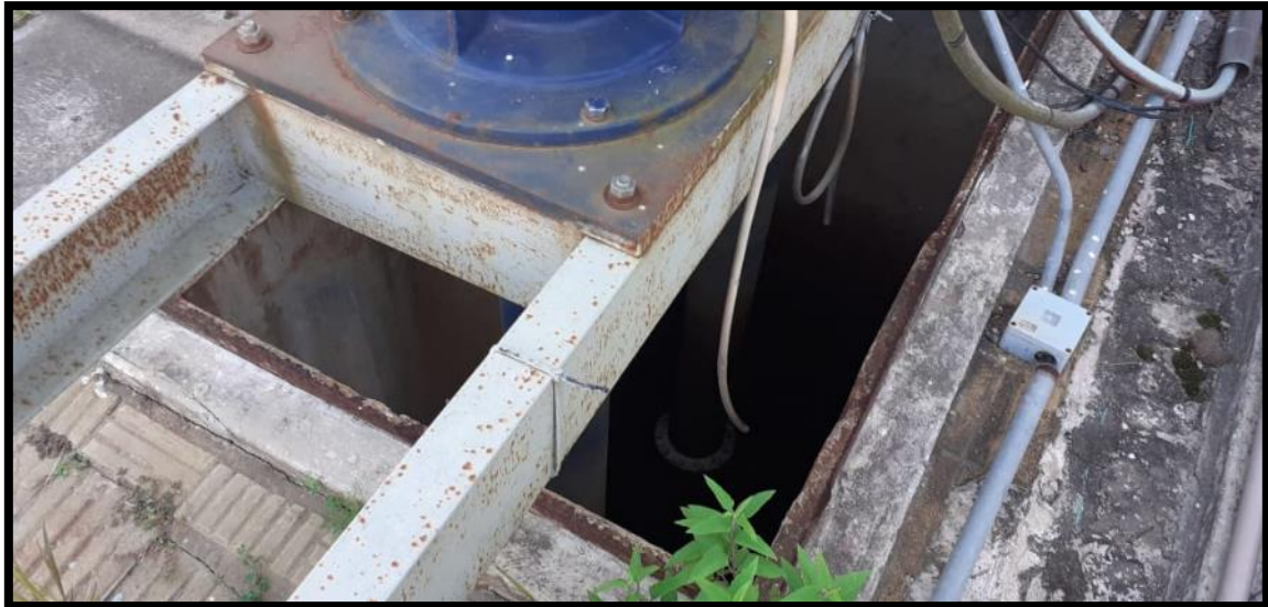
Imagen 2.2.9 - Toma de la Bomba Vertical sobre el pelo de agua.
