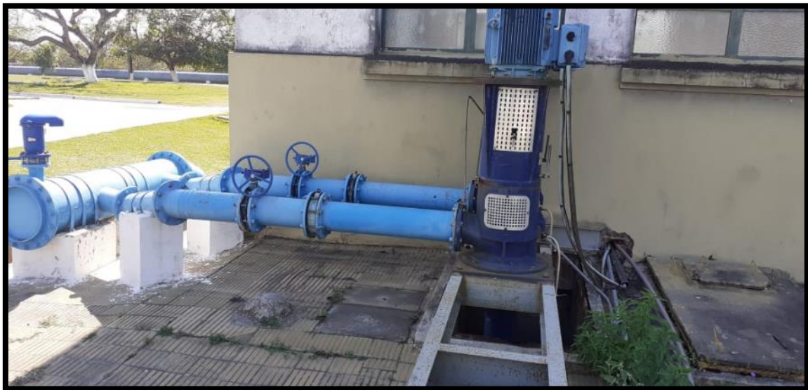
Imagen 2.2.8 - Bomba Vertical de la Planta Potabilizadora N°1.
