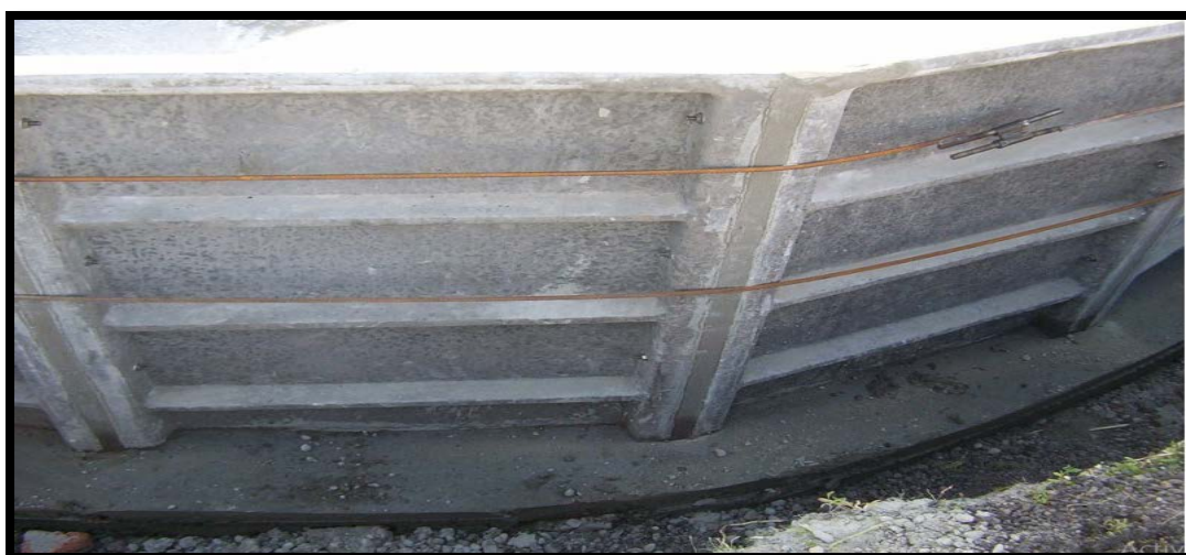
Imagen 3.2.1.5 - Lado exterior donde se ve refuerzos de hierro de 10mm.
