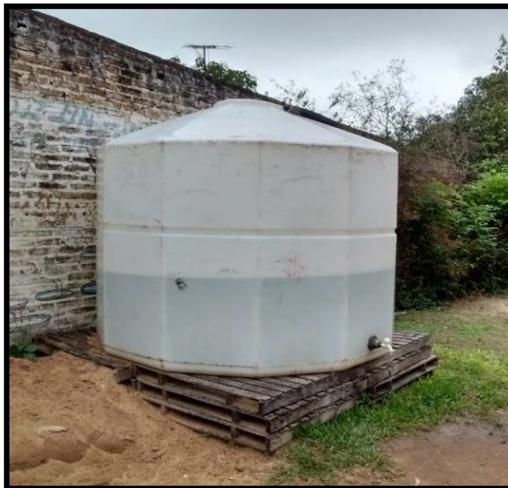
Foto 2.11-Tanque de reserva para consumo directo de agua en la entrada del barrio San Pedro Pescador.
