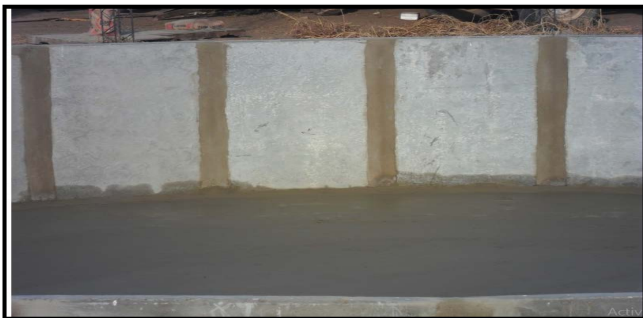
Imagen 3.2.1.3 - Juntas internas entre placas.
