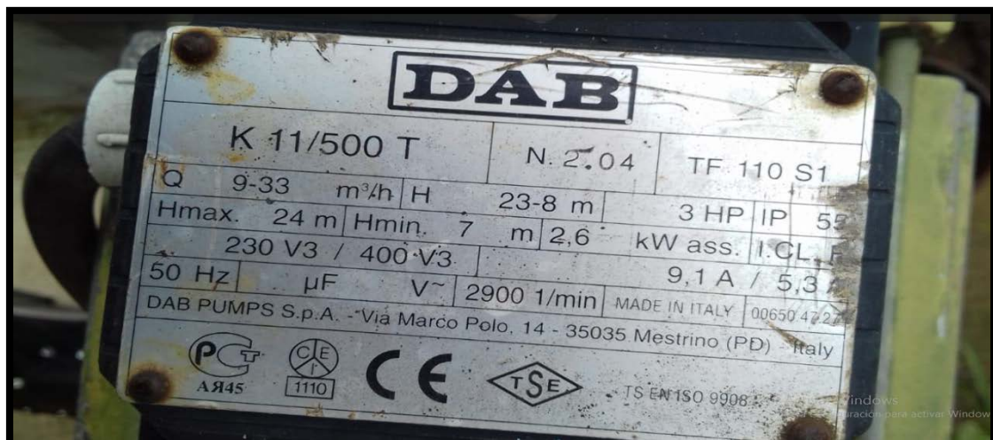
Foto 3.2.2.2 - Características Bomba existente B° San Pedro Pescador
