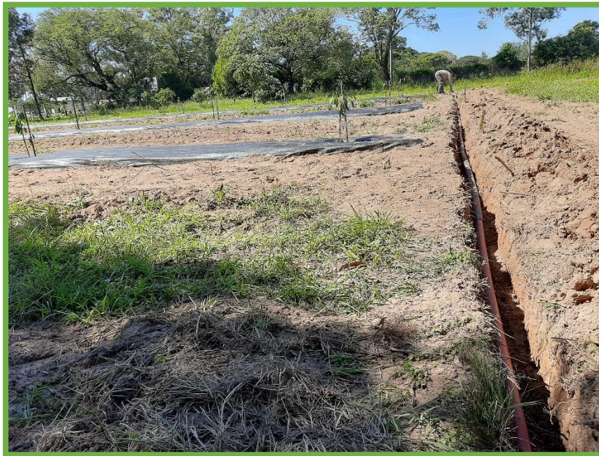
Figura 9: Instalación de líneas de riego
