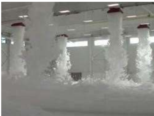
Ilustración 29: Aspersores de espuma y agua en funcionamiento.
