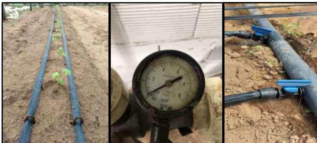
➤ Cintas de riego, lectura del manómetro, llaves de paso (fig. 16)
