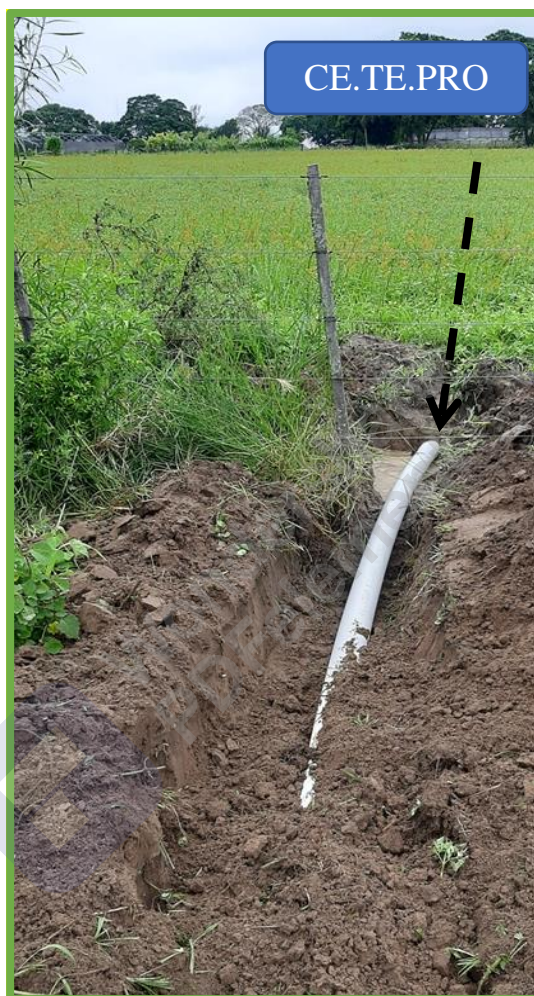
Figura 11: Instalación del caño PVC.
