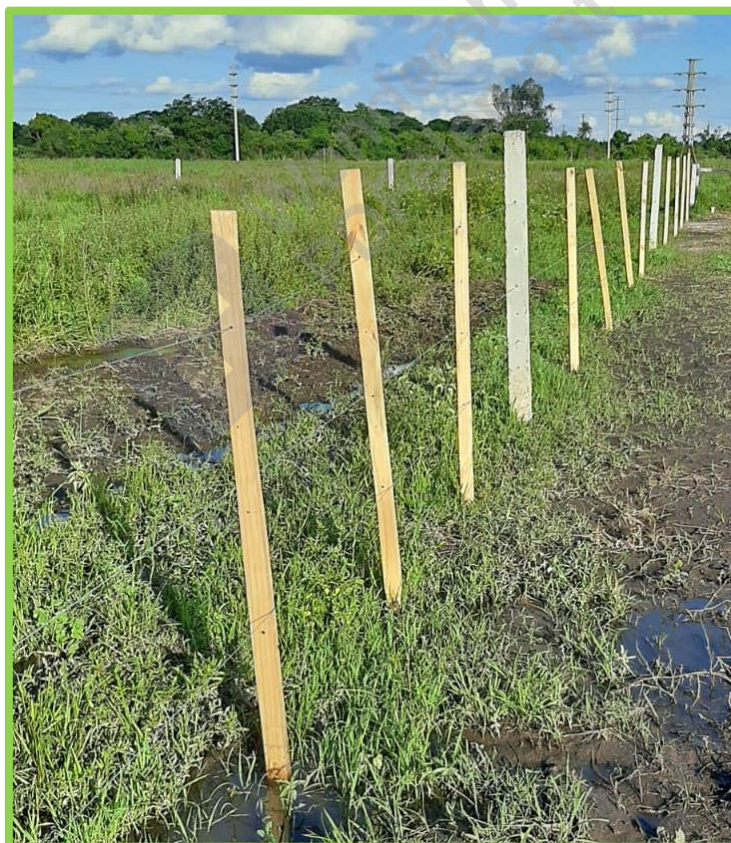
Figura 14: Varillas de madera entre los postes de hormigón para tensar el alambre.
