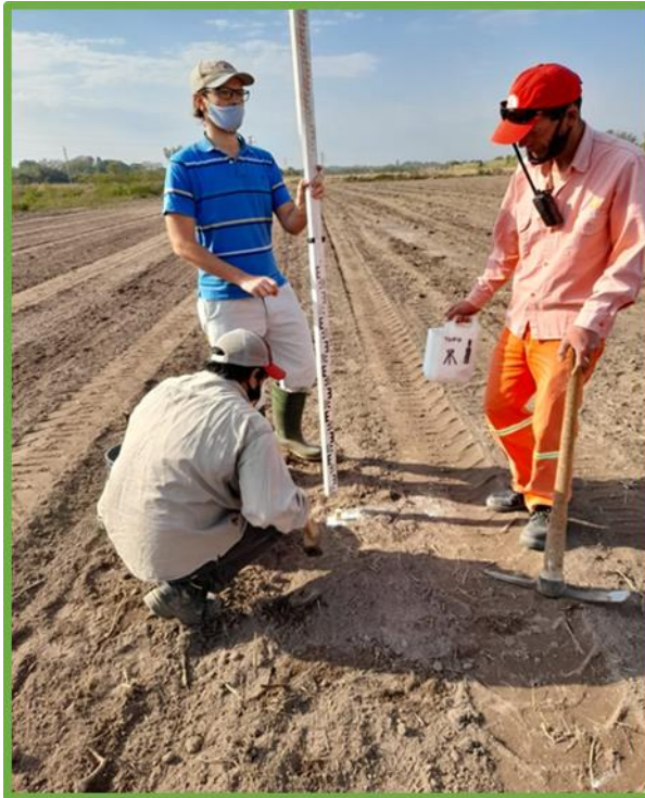
Figura 19: Colocación de las estacas.
