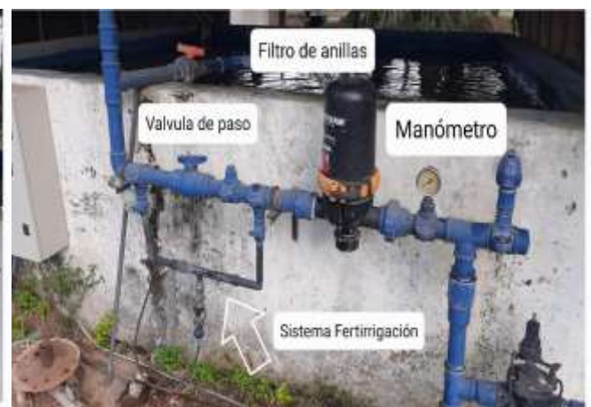
Imágenes n° 28 y n° 29. Componentes del sistema de riego, cada una de sus partes.
