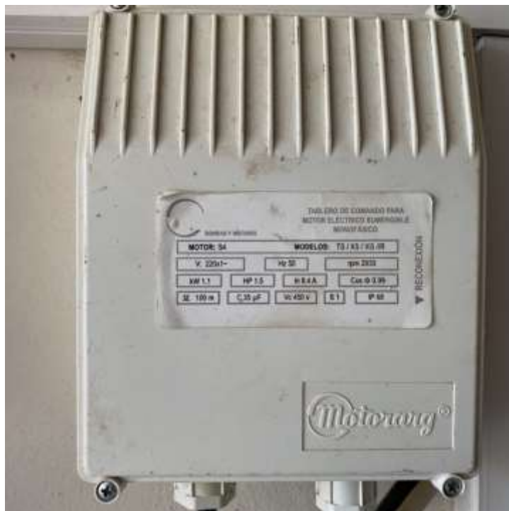
Figura N° 28: Tablero de comando bomba Motorarg electrosumergible.
