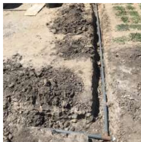
Figura N° 31: Instalación de cañerías de riego.
