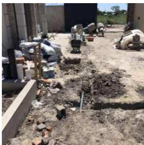
Figura N° 31: Instalación de cañerías de riego.
