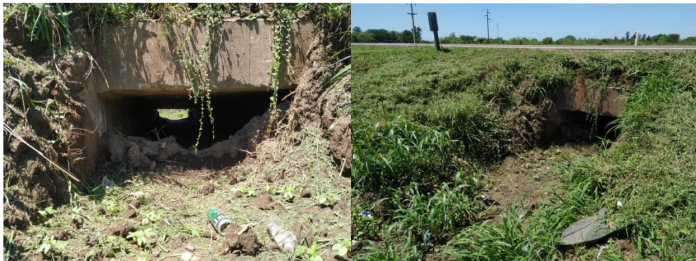
Fig. 14: Alcantarilla 3. Mantenimiento medio, la vegetación no impide el acceso. (Fuente: Elaboración propia en base a Relevamiento)
