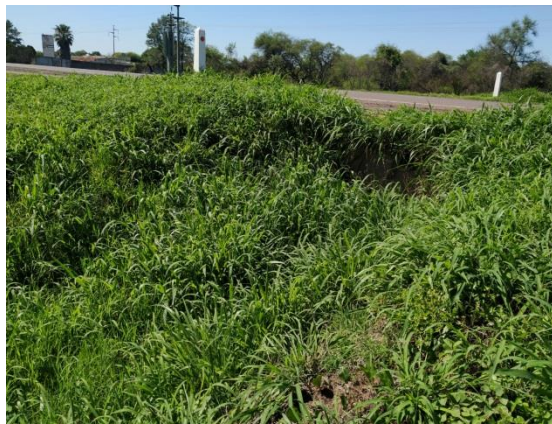
Fig. 8: Alcantarilla 1, totalmente tapada por vegetación. (Fuente: Elaboración propia en base a Relevamiento)
