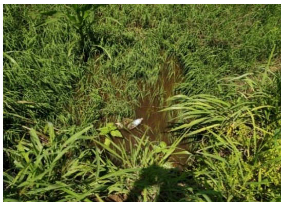
Fig. 18: Alcantarilla 4, totalmente tapada por vegetación. (Fuente: Elaboración propia en base a Relevamiento)
