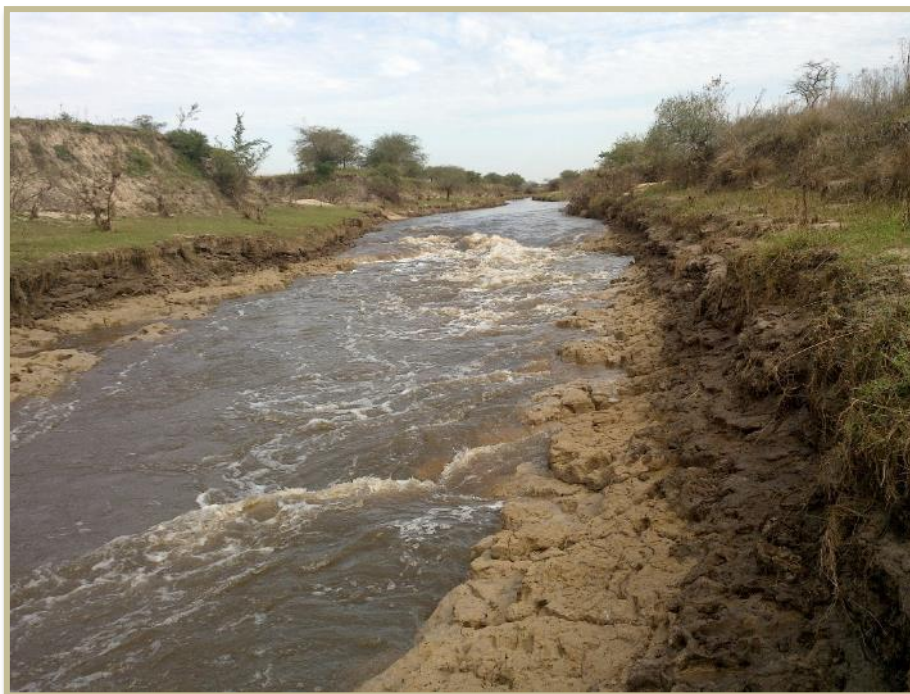
Cauce del Arroyo Iribú Cuá 950m aguas arriba de la RNN12 (desnivel en fondo del cauce por erosión)
