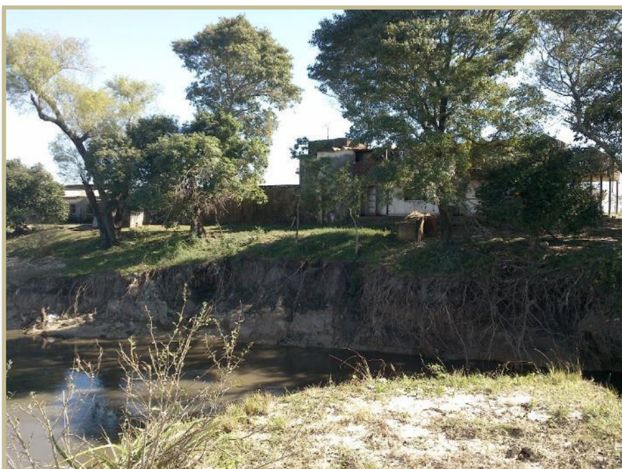
Construcciones cercanas al Cauce del Arroyo Iribú Cuá 100m aguas arriba de la RNN12
