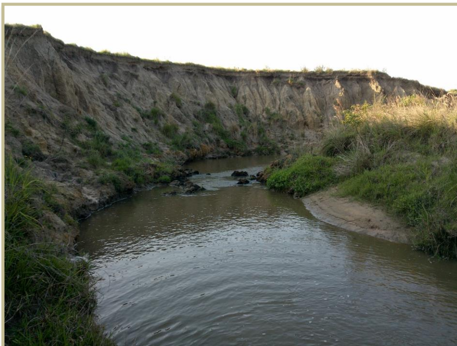
Cauce del Canal Berón de Astrada 250m aguas abajo de la RNN12
