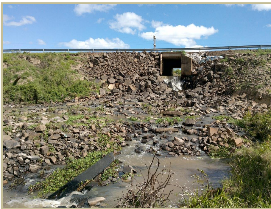
Cauce del Canal Berón de Astrada 30m aguas abajo de la RNN12
