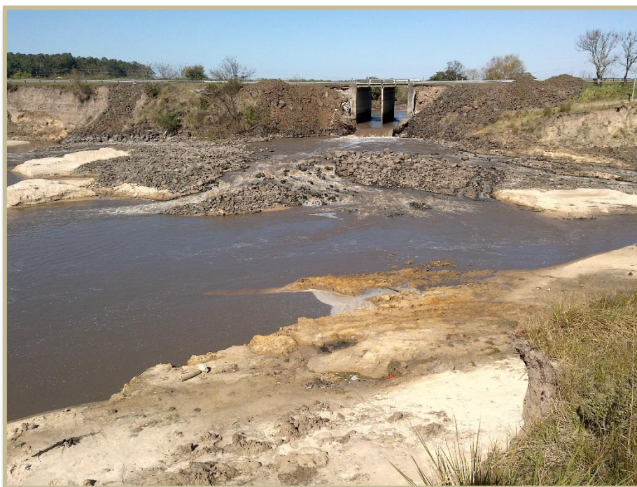
Cauce del Arroyo Santa María 100m aguas abajo de la RNN12
