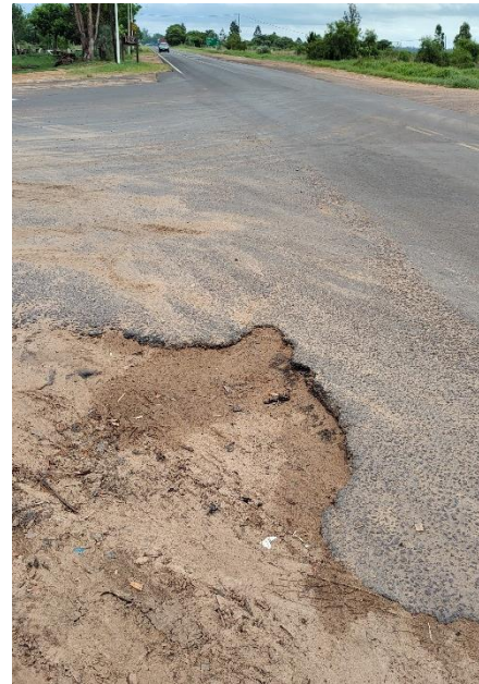
Fig. N°10 y 11. Baches de borde y deterioro de banquina. Fuente: Foto tomada por nosotros.
