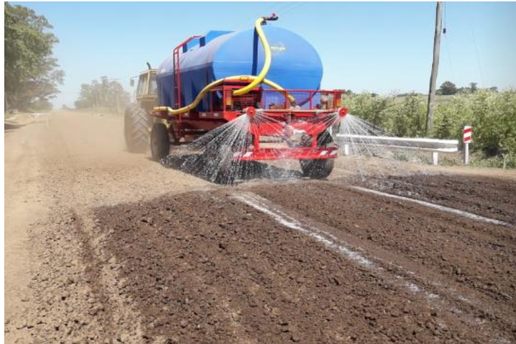
Figura N°92. Humectación de la capa tratada (Fuente: http://www.vialidad.gba.gov.ar ).
