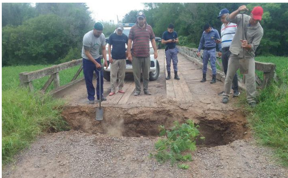
Imagen I.11. desmoronamiento del puente. (Fuente: municipio de Colonia Benítez, 2023)
