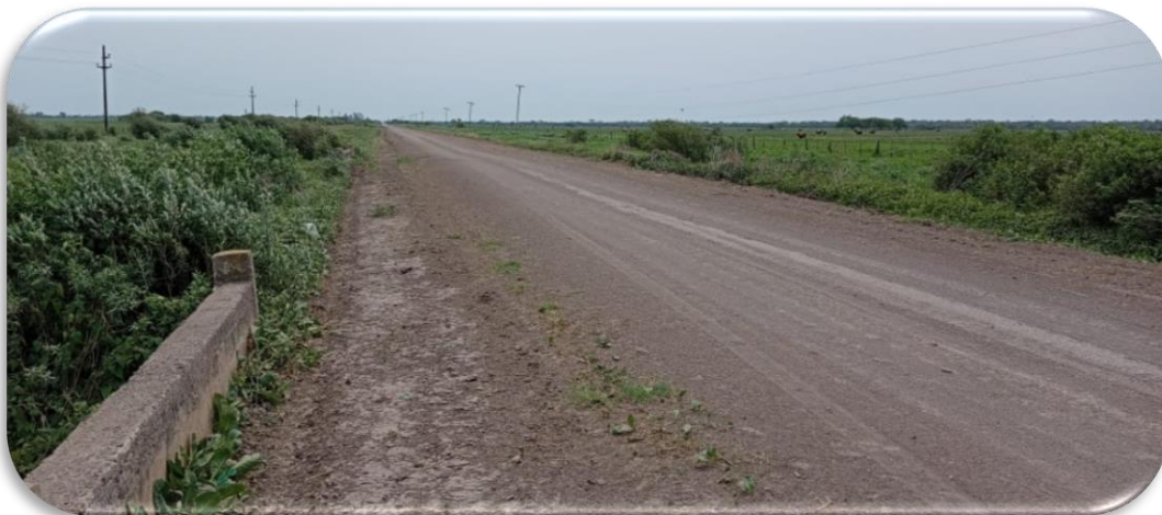
Imagen 3.3: Topografía sobre RPN13 en cercanías a Charadai – (Fuente: Elaboración propia)
