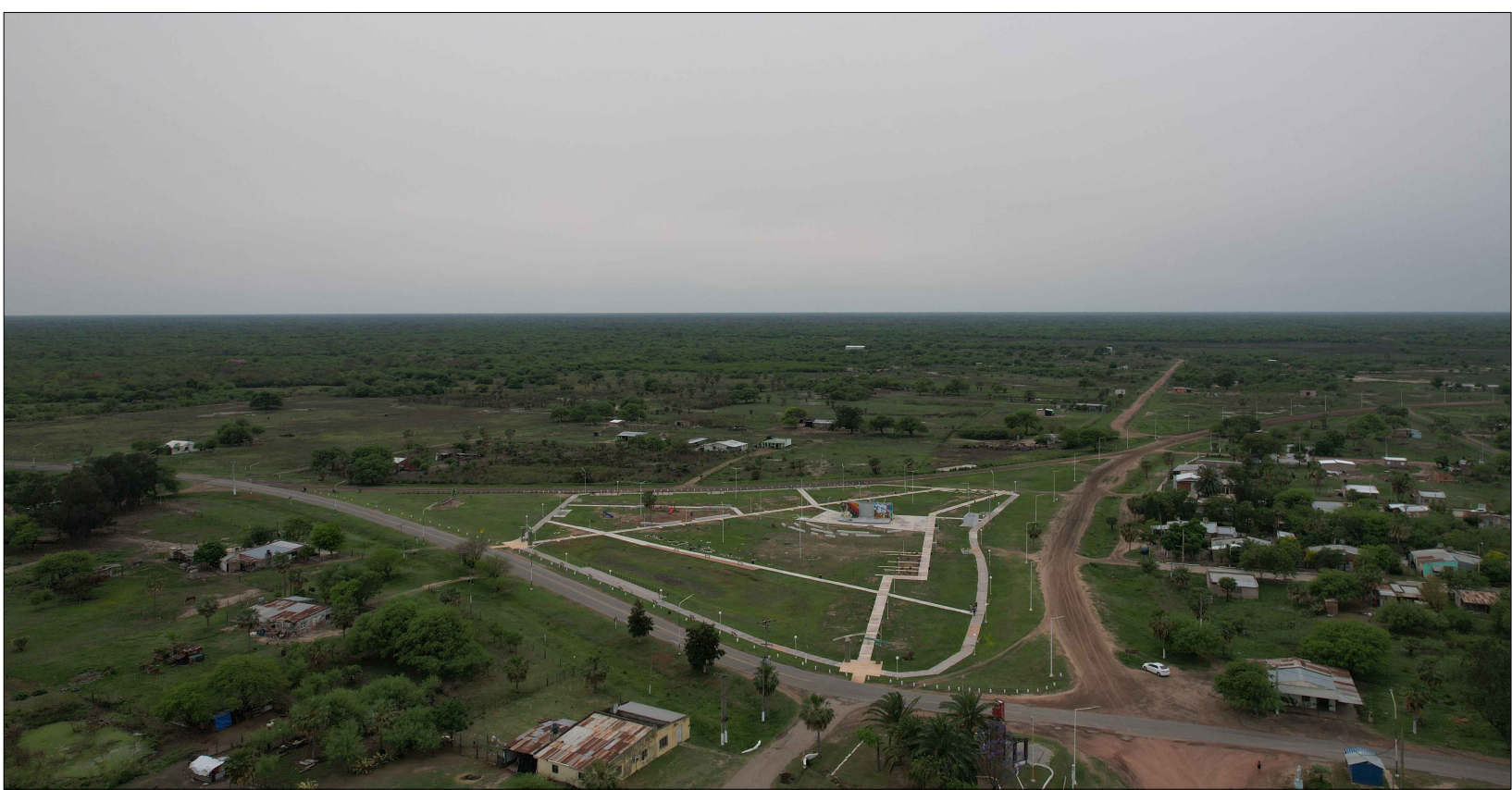
INTERSECCIÓN ACTUAL VISTA OESTE
