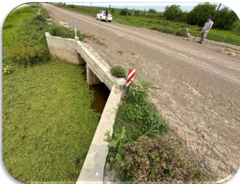
Imagen 7.37: Alcantarilla canal 1 – 2 tramos de 1.20m x 2.00m - (Fuente: Elaboración propia)
