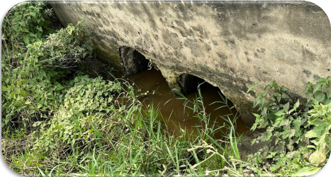
Imagen 7.34: Alcantarilla de hormigón armado 2\phi = 0.80\text{m} - (Fuente: Elaboración propia)
