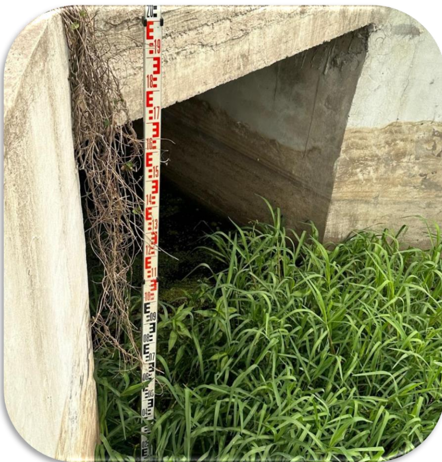
Imagen 7.41: Alcantarilla sobre canal 2 – 1.70m x 1.80m - (Fuente: Elaboración propia)
