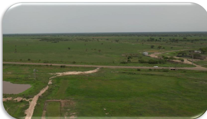
Imagen 7.38: Fotografía aérea canal 1 y alcantarilla - (Fuente: Elaboración propia)
