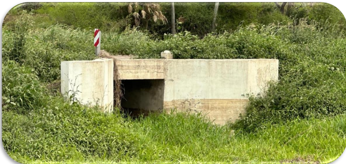
Imagen 7.40: Alcantarilla sobre canal 2 – 1.70m x 1.80m - (Fuente: Elaboración propia)
