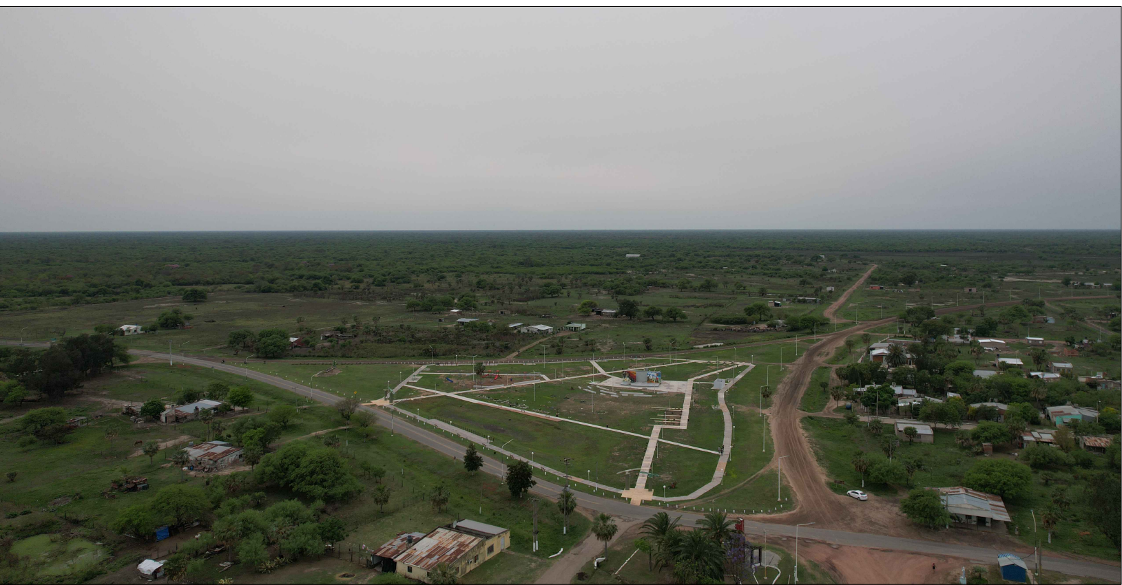
INTERSECCIÓN ACTUAL VISTA OESTE
