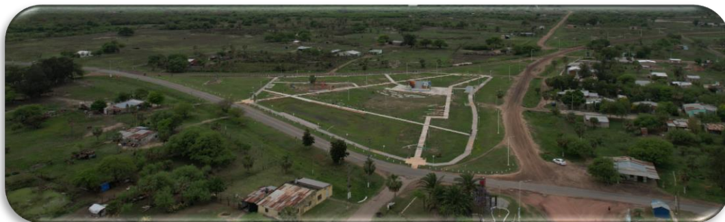
Imagen 1.7: Fin de Tramo III (Intersección RPN°4-RPN°13. Localidad de Samuhú) – (Fuente: Elaboración Propia).
