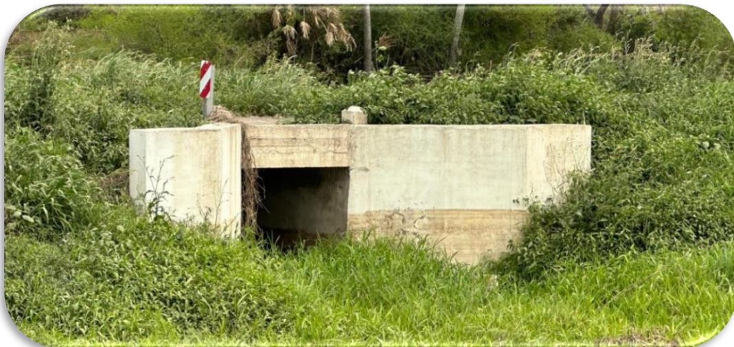
Imagen 7.51: Alcantarilla sobre canal 2 – 1.70m x 1.80m - (Fuente: Elaboración propia)
