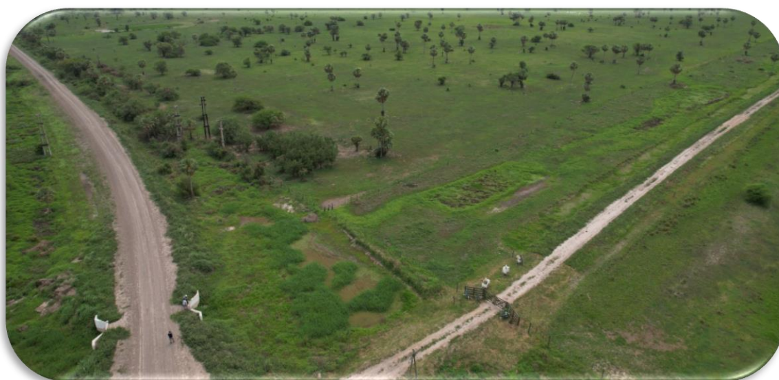
Imagen 7.39: Fotografía aérea canal 2 y alcantarilla - (Fuente: Elaboración propia)
