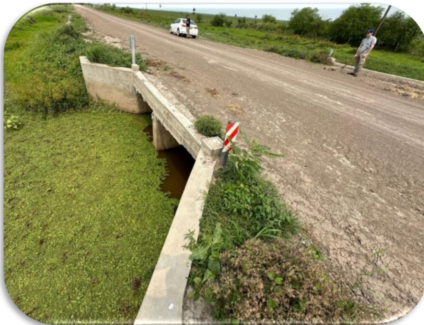
Imagen 7.50: Alcantarilla canal 1 – 2 tramos de 1.20m x 2.00m - (Fuente: Elaboración propia)
