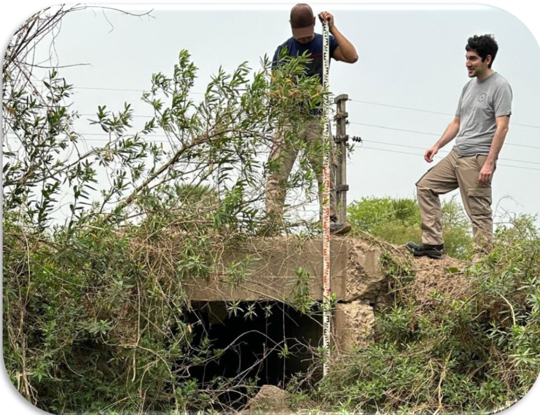
Imagen 7.27: Alcantarilla rectangular 1m * 1.50m-(Fuente: Elaboración propia)
