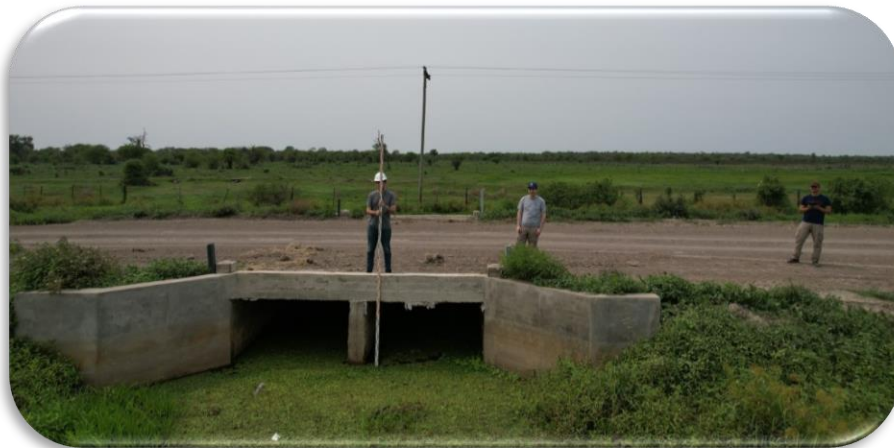
Imagen 7.36: Fotografía aérea Alcantarilla canal 1 – 2 tramos de 1.20m x 2.00m - (Fuente: Elaboración propia)
