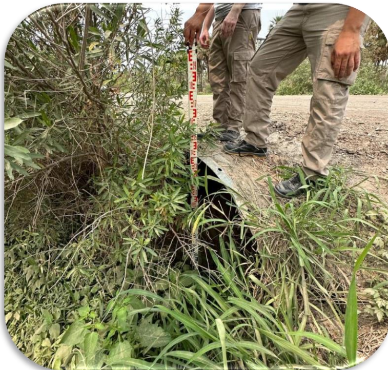
Imagen 7.35: Alcantarilla de metálica \phi = 1.40\text{m} - (Fuente: Elaboración propia)
