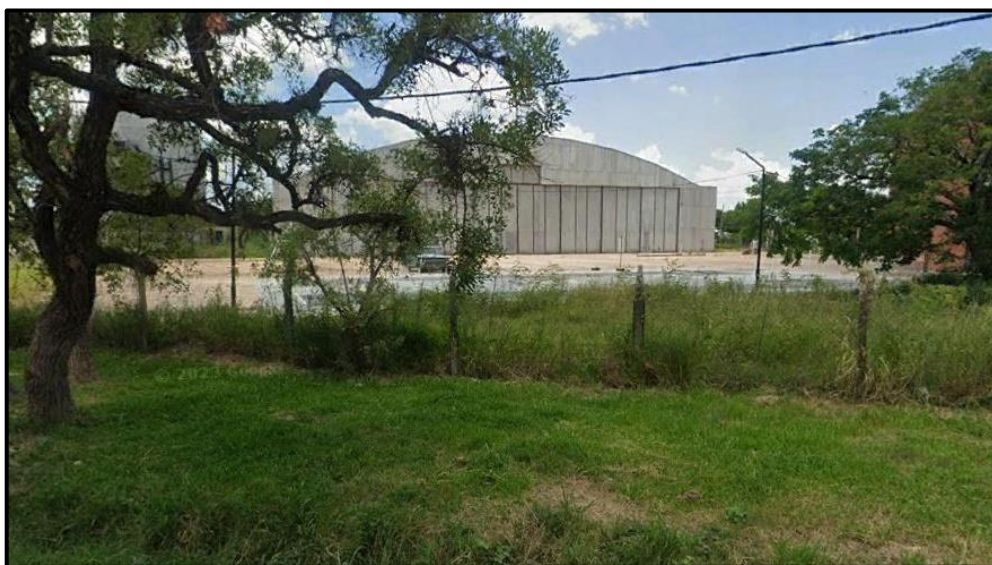
Figura 9 - Vista del área dedicada a estacionamiento, junto a la cancha de básquet y la residencia estudiantil de la UNNE (Fuente: Google street view, 2024).
