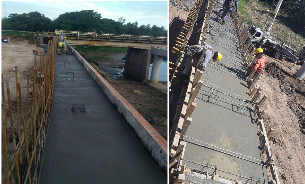
Figura 56: Armado de bancada de vigas.
