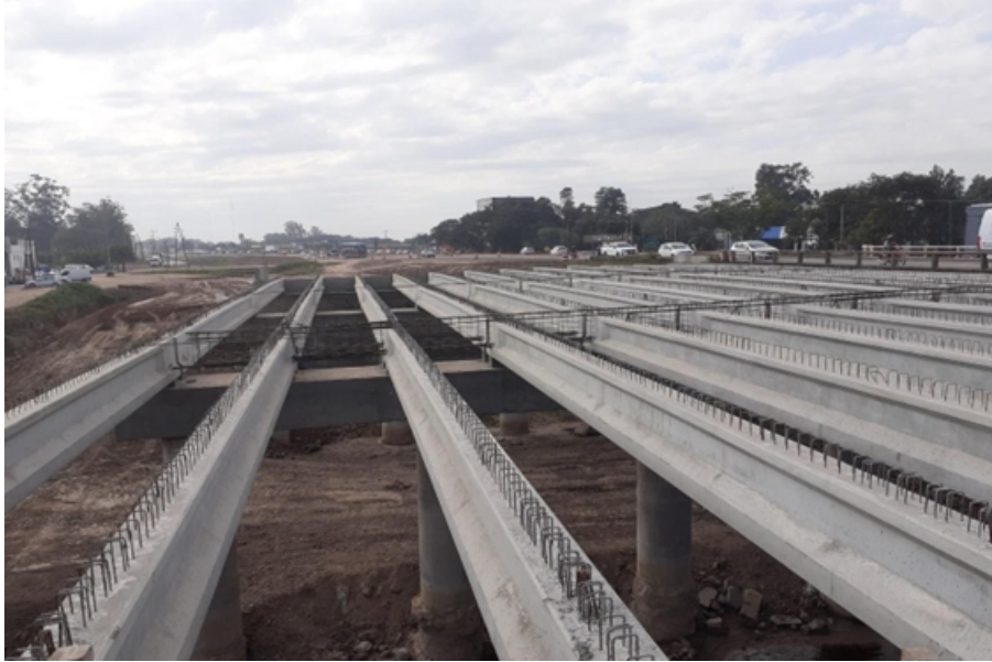
Figura 62: Armado de vigas secundarias. Fuente: Cátedra Hormigón Armado II.
