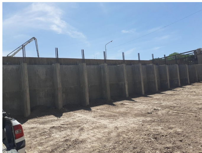
Figura 55: Armado de estribos. Fuente: Cátedra Hormigón Armado II.
