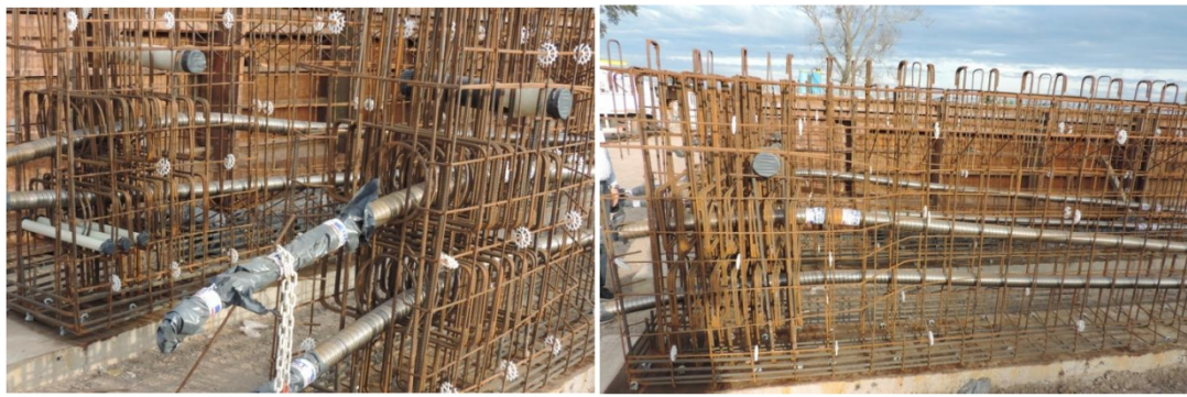
Figura 99: Fotografía armadura de viga principal, vista longitudinal. Fuente: Melmix Hormigones.
