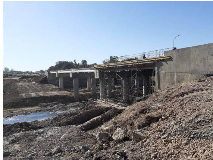
Figura 60: Armado de losa de tablero sin prelosa.
