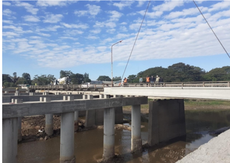
Figura 58: Colocación de vigas principales. Fuente: Cátedra Hormigón Armado II.
