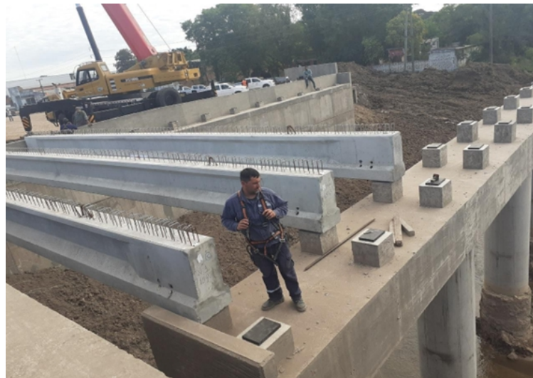
Figura 59: Colocación de vigas principales. Fuente: Cátedra Hormigón Armado II.
