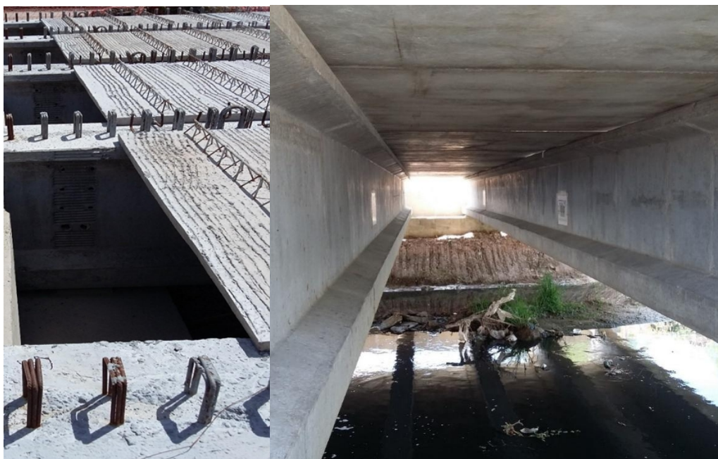
Figura 61: Colocación de prelosa.
