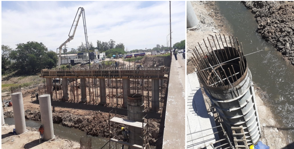
Figura 54: Armado de pilas. Fuente: Cátedra Hormigón Armado II.
