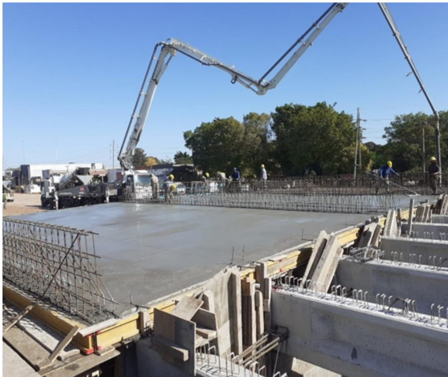
Figura 63: Hormigonado de losa de tablero. Fuente: Cátedra Hormigón Armado II.
