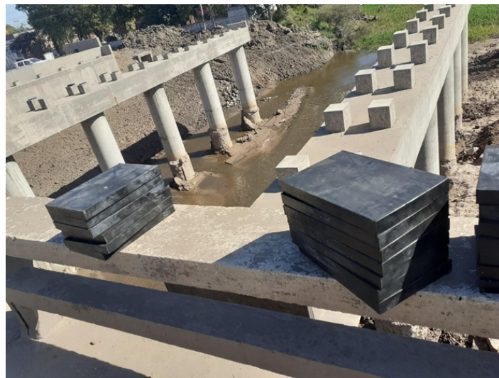
Figura 57: Armado de apoyos.
