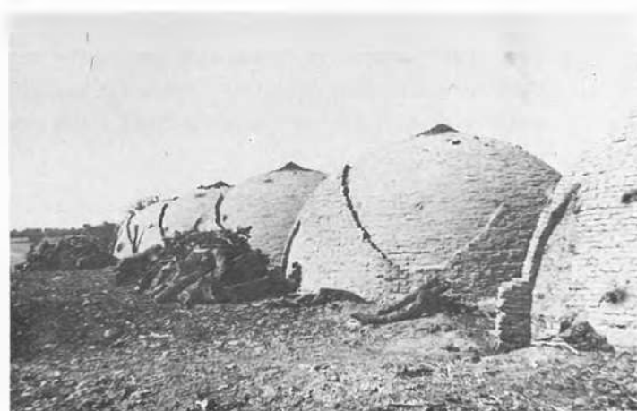
Foto 27. Hornos de manpostería para la elaboración de carbón vegetal. Fortín Olmos, en el NE de la Provincia de Santa Fe. (Fot. N. Meichtry).
