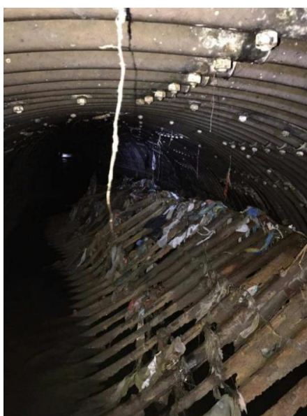
Fuente 27. Tubo de desagüe de Chapa Galvanizada.
