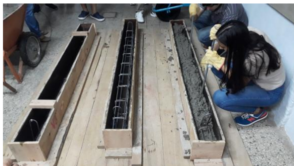
Figura 3: Elaboración de las vigas.
