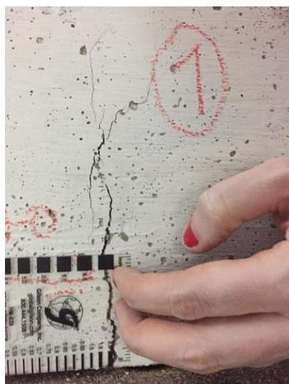
Figura 10: Medición de anchos de fisuras.
