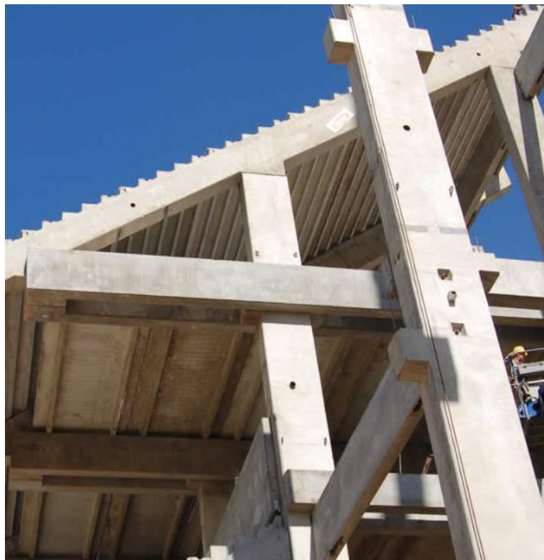
Imagen 7.7 Columnas prefabricadas en las que se apoya la viga tribuna (Fuente: https://www.astori.com.ar/multimedia/sistemas/5/08.jpg ).
