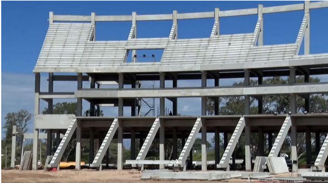
Imagen 7.4. Sistema constructivo a base de hormigón armado prefabricado del estadio Madre de Ciudades (Fuente: https://www.diariopanorama.com/noticia/318322/conoce-detalles-construccion-estadio-nico-santiago-estero ).
