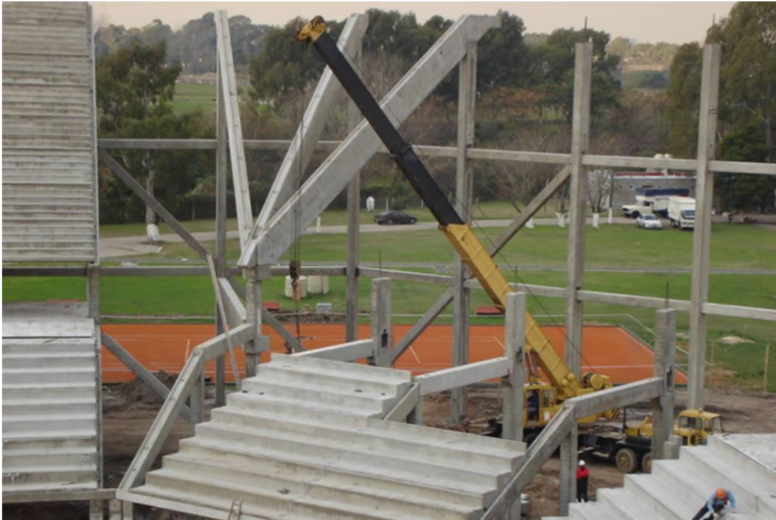
Imagen 7.2 Izaje y colocación de gradas de hormigón armado prefabricado (Fuente: https://www.astori.com.ar/multimedia/sistemas/5/08.jpg ).
