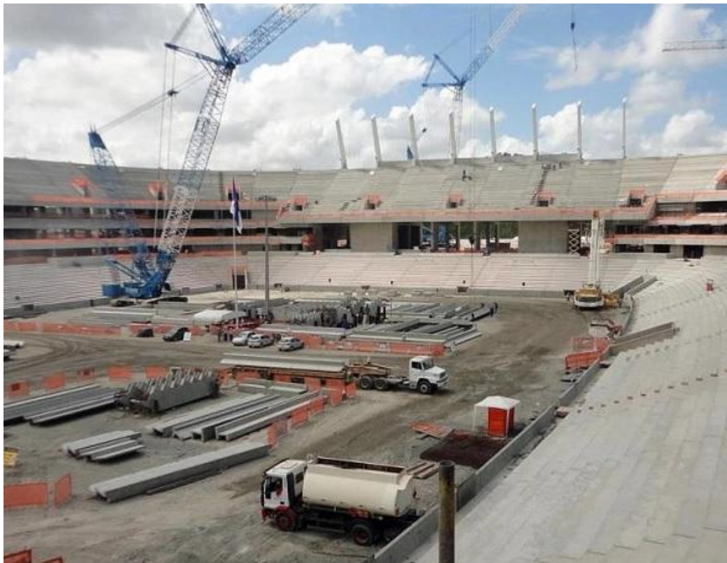
Imagen 7.5 Sistema constructivo a base de hormigón armado prefabricado del estadio Itaipava Arena Pernambuco (Fuente: https://civilizacaoengenhira.wordpress.com/2012/11/05/pre-fabricado-faz-arenas-da-copa-virarem-realidade/ ).
