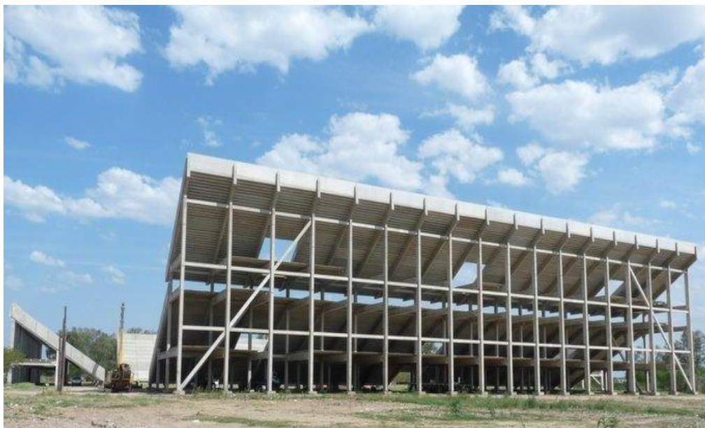
Imagen 7.3. Sistema constructivo a base de hormigón armado prefabricado del estadio Centenario (Fuente: https://www.skyscrapercity.com/threads/resistencia-nuevo-estadio-del-club-sarmiento.965246/ ).
