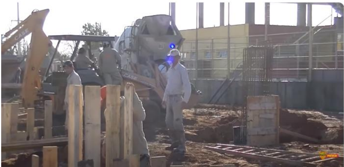
Imagen 1.26. Hormigonado in situ de las fundaciones (Fuente: https://www.youtube.com/watch?v=NqHU2Z_Lml4 ).
