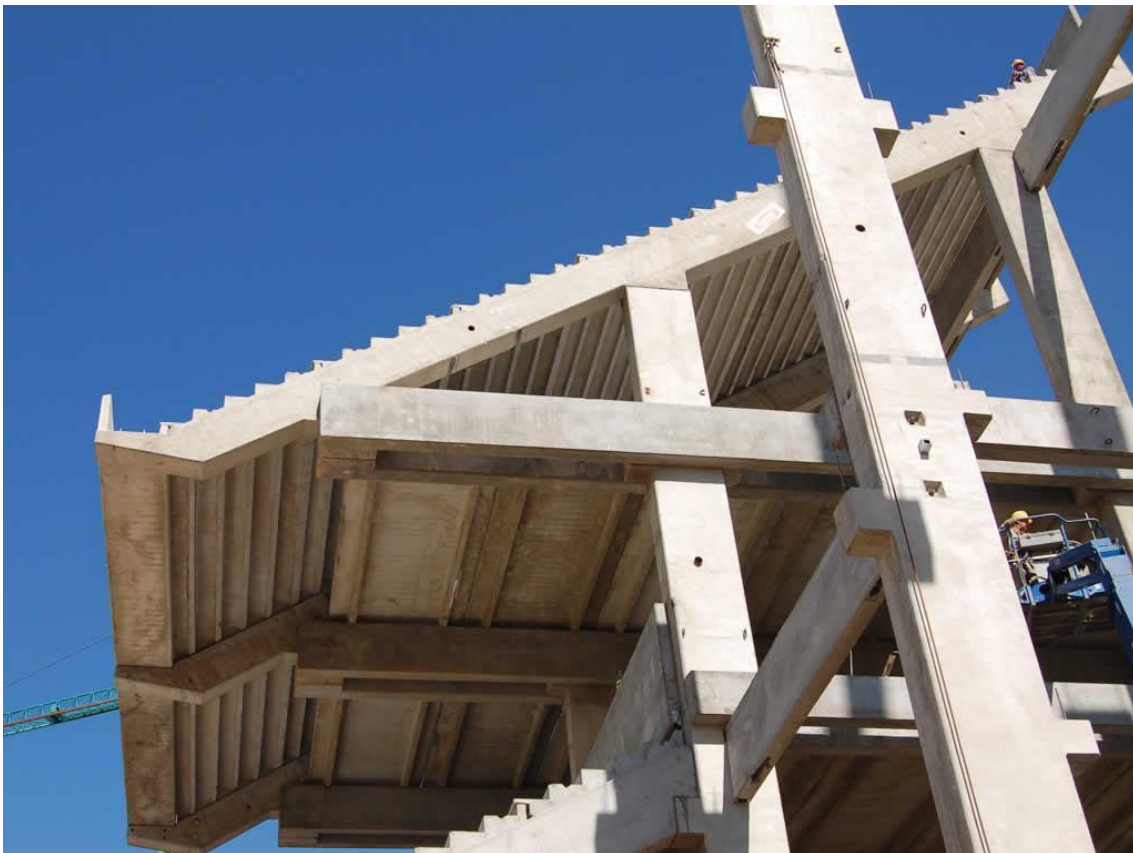
Imagen 7.1 Estructura conformada por pórticos donde se apoyan las gradas (Fuente: https://www.astori.com.ar/multimedia/sistemas/5/09.jpg ).
