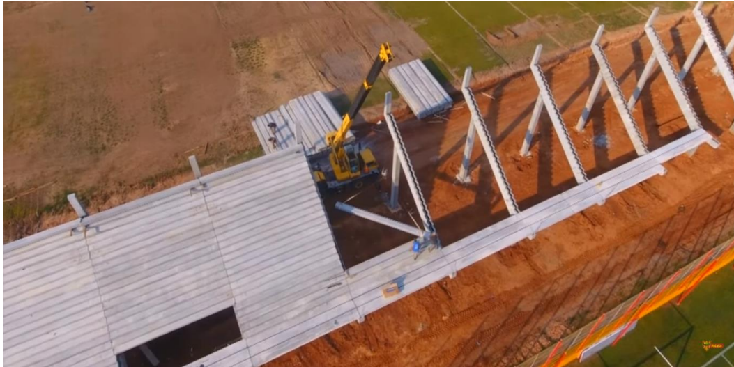
Imagen 1.25. Colocación de las vigas y columnas de hormigón armado prefabricado (Fuente: https://www.youtube.com/watch?v=NqHU2Z_Lml4 ).
