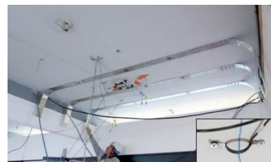
Figura 7. Reparación de una losa en un edificio escolar en Nieppe, Lille, Francia, mediante láminas de AMF [25].
