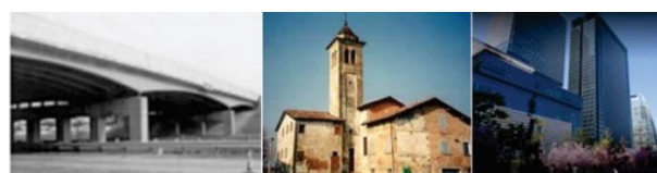
Figura 6. a. Puente de carretera postesado con AMF, Michigan, Estados Unidos. b. Iglesia San Giorgio en Trignano, Italia, reforzada con dispositivos antisísmicos basados en AMF. c. JP Tower Nagoya, construida con 16 amortiguadores antisísmicos de AMF Fe-Mn-Si-Cr-Ni
