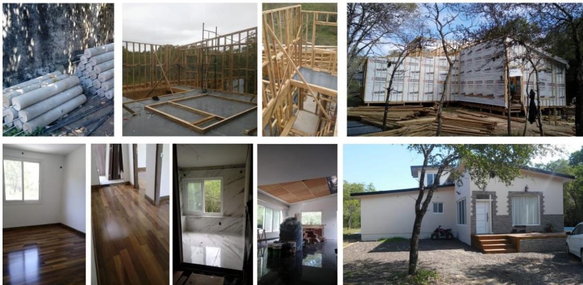
Fig. 4: Proceso constructivo y terminaciones del Caso 2. Fuente: Erick Kennedy, autor de la obra.
