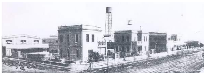
Fig. 2 – Il complesso industriale nella situazione originaria
