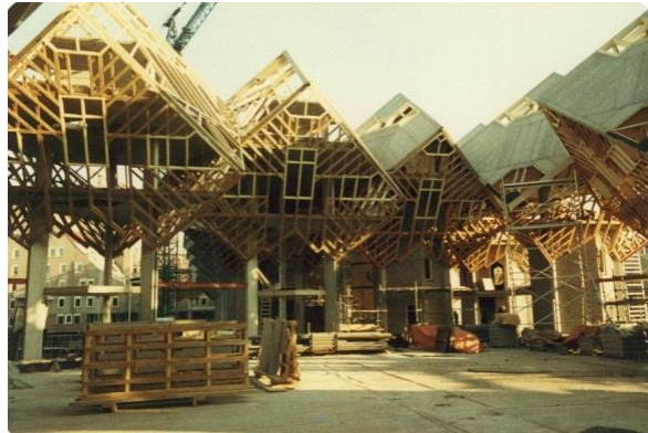
Fig. 7 - Esqueleto de madera Casa Kubo. Fuente: http://www.kubuswoning.nl/woningen.html
