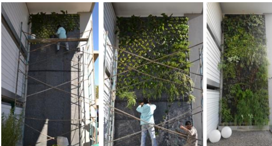
Fig. 2: Proceso de construcción del muro verde.
