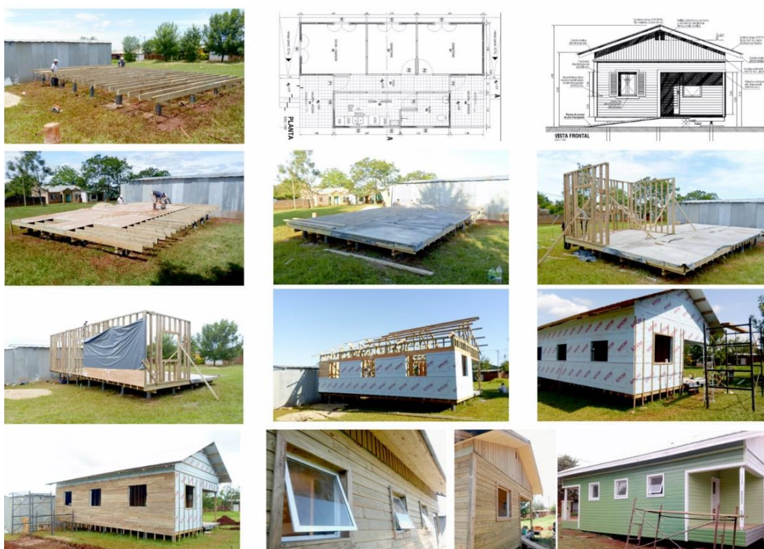
Fig. 2: Planos y fotografías del proceso constructivo de viviendas sociales INVICO en la localidad de Virasoro. Fuente: INVICO (planos) y Erick Kennedy fotografías.
