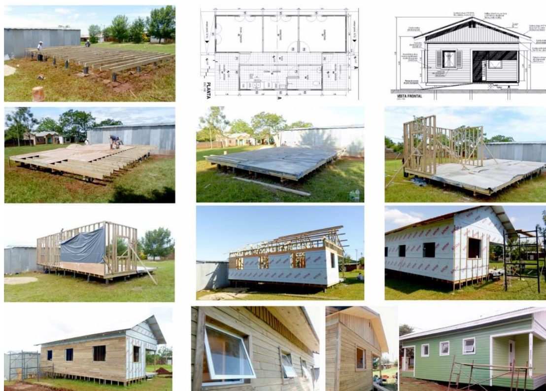
Fig. 3 Planta prospecto e fotografie delle fasi realizzative delle viviendas sociales INVICO presso la località di Virasoro. Fonte: INVICO (disegni) e Erick Kennedy (fotografie).
