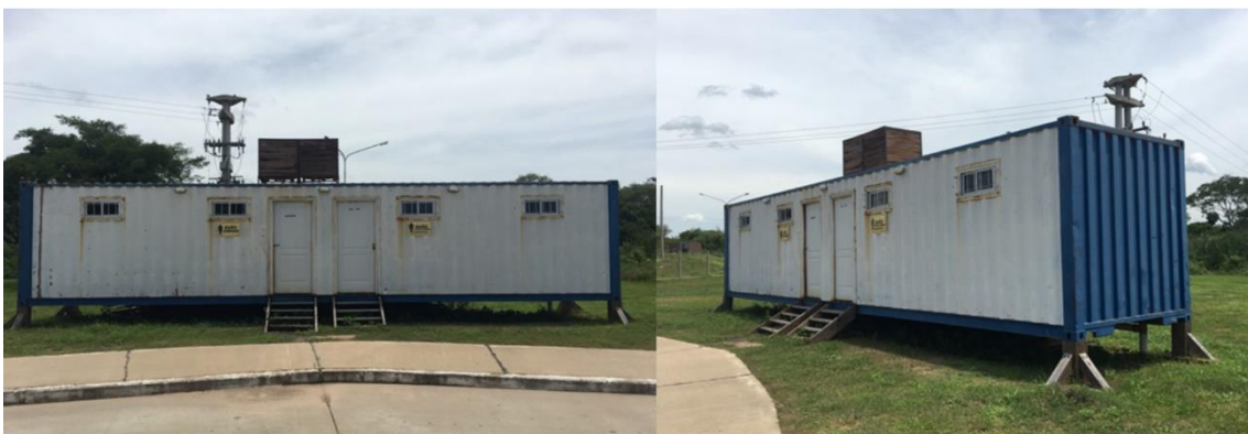
Figura 1: sanitario existente del Parque de la Democracia. Fuente: fotografías de elaboración propia.
