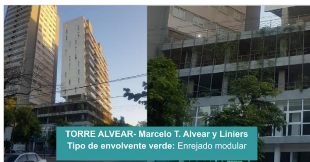
Figura 15: Envolvente verde de la Torre Alvear. Elaboración propia (2021).
