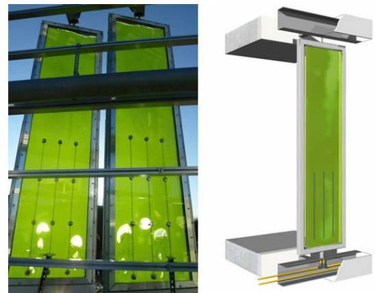
Fig. 8: Casa de algas. Detalle de paneles de la fachada. Fuente:
