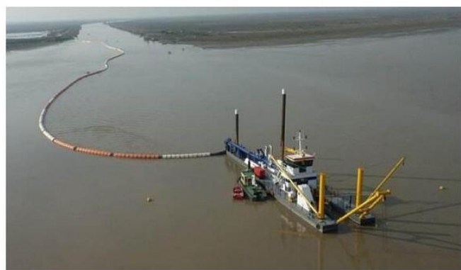
Figura 11: Dragado para condiciones de disposición del material en forma controlada
