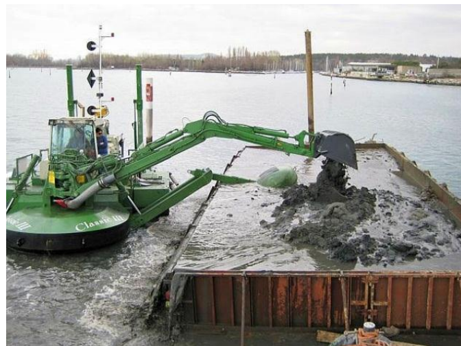
Figura 12: Dragado para condiciones de disposición del material con necesidad de confinamiento y/o tratamiento
