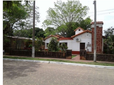
Foto 3. Arquitectura Moderna / Casa Chalet Californiano. Fuente: Proyecto "Atlas Patrimonio". 2013-2017. Colección CEHAU.
