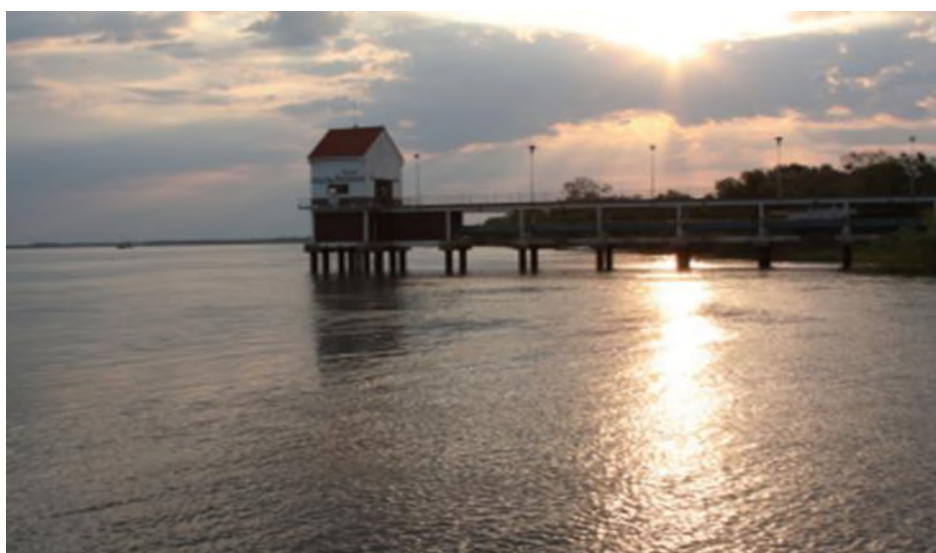
Imagen N°:1 toma de captación, imagen tomada de internet. Fuente: https://www.aguasdecorrientes.com/524/toma-de-agua
