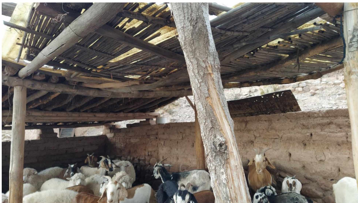
Foto 24: techo de las instalaciones construido con materiales disponibles en la zona
