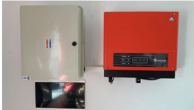
Fig. 83: Instalación de inversor y tablero de controles en las viviendas. Fuente: Luis Vera.
