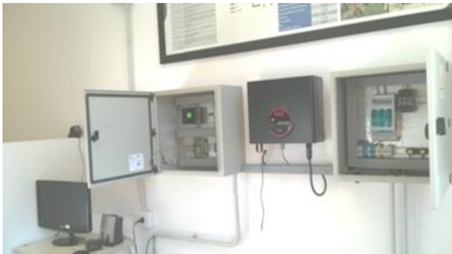
Fig. 41: Tableros eléctricos del SFCR. Fuente: (Pilar, Vera, & Roibón, 2017)
