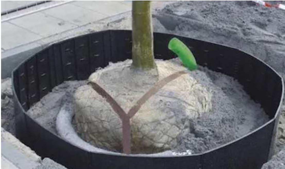
Figura 40. Barreras plásticas encastrables como barrera de raíces (fuente: Arq. Marcelo Seia).
