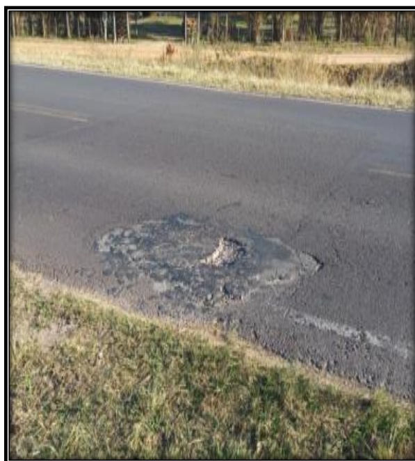
Figura 43. Bache generado por encima de la alcantarilla ( Fuente: Elaboración propia )
