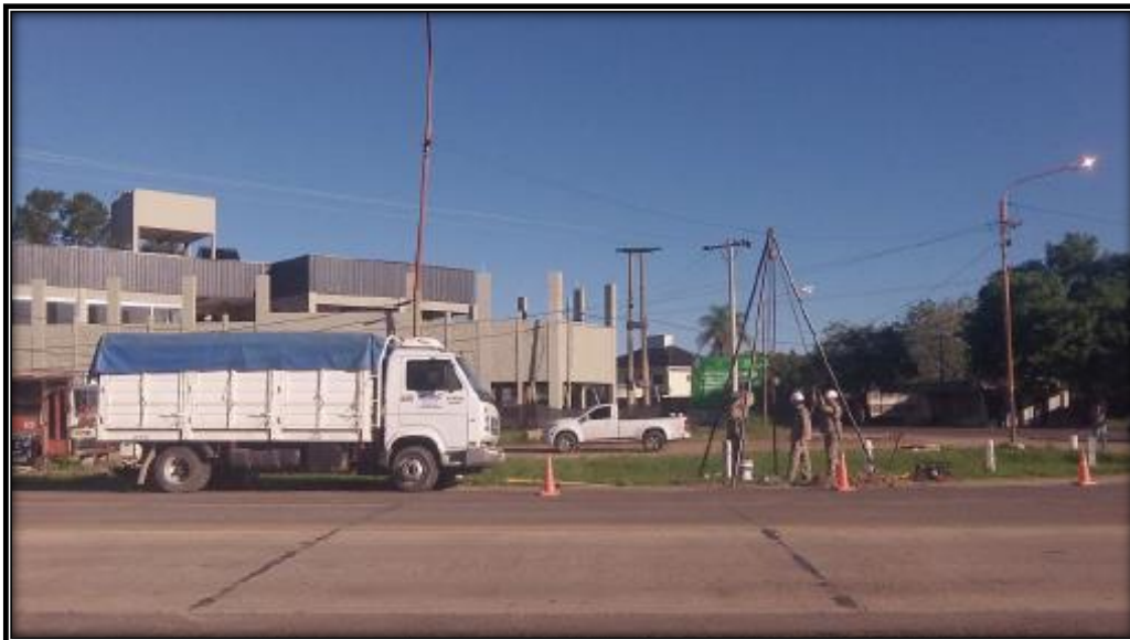
Figura 22. Extracción de la muestra P2 (Fuente: Informe del estudio de suelo realizado por SIGMA SA, 2016)
