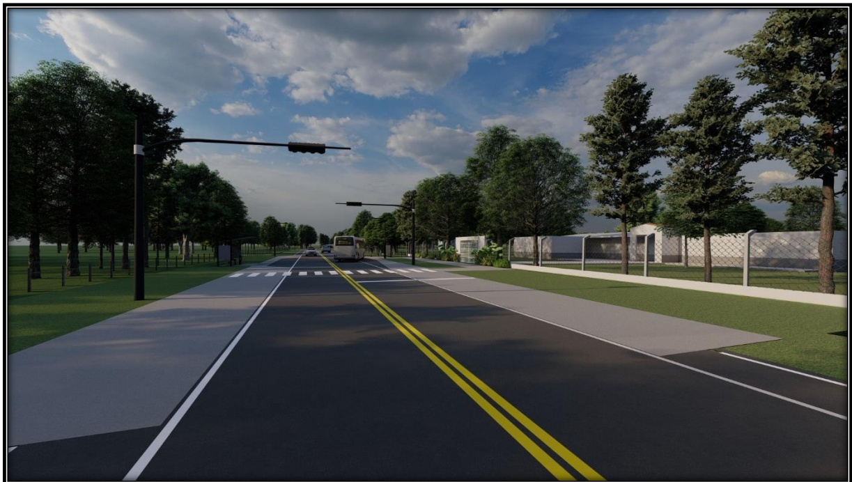
Figura 189. Semaforización del cruce peatonal ( Fuente: Elaboración propia )
