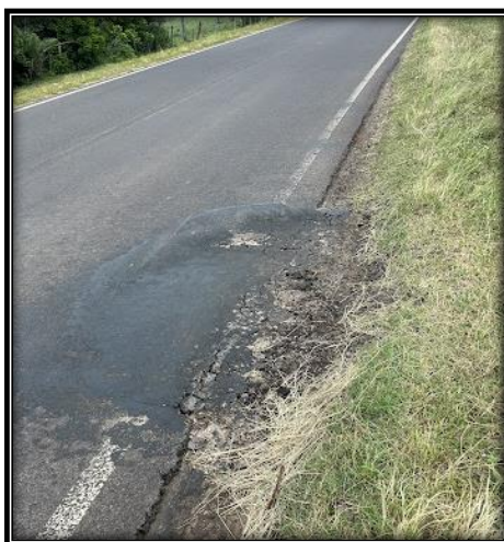
Figura 29. Bache sobre la Prog. 6+233 ( Fuente: Elaboración propia )
