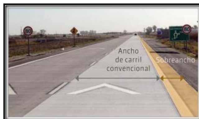
Figura 123. Sobreancho de calzada de hormigón (Fuente: Manual ICPA , 2014)
