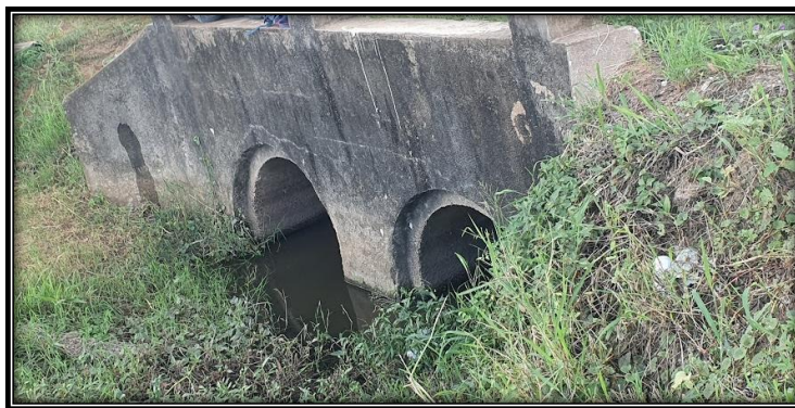
Figura 55. Salida hacia RP N°5 de la alcantarilla (Fuente: Elaboración propia).
