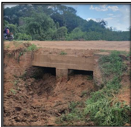
Figura 54. Alcantarilla de ladrillo y hormigón sobre la Prog. 3+532 ( Fuente: Elaboración propia )
