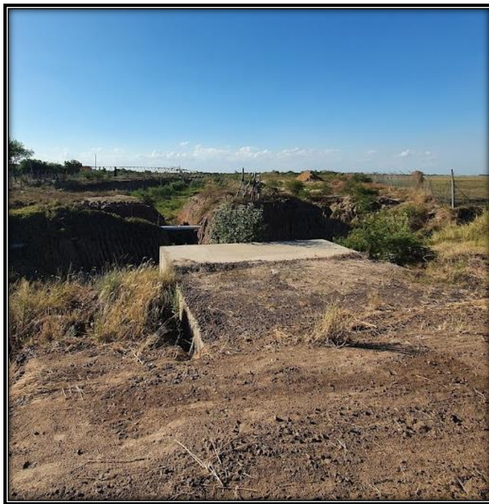
Figura 65. Salida de la alcantarilla y canal de grandes dimensiones que descarga en el río Paraná ( Fuente: Elaboración propia )
