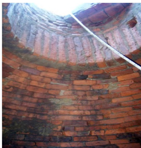
Fotos 54 y 55. Foto detalle del interior del pozo, donde se puede observar la forma abovedada del cuerpo del pozo. (Fotos: Lic. Belén Aguirre)
