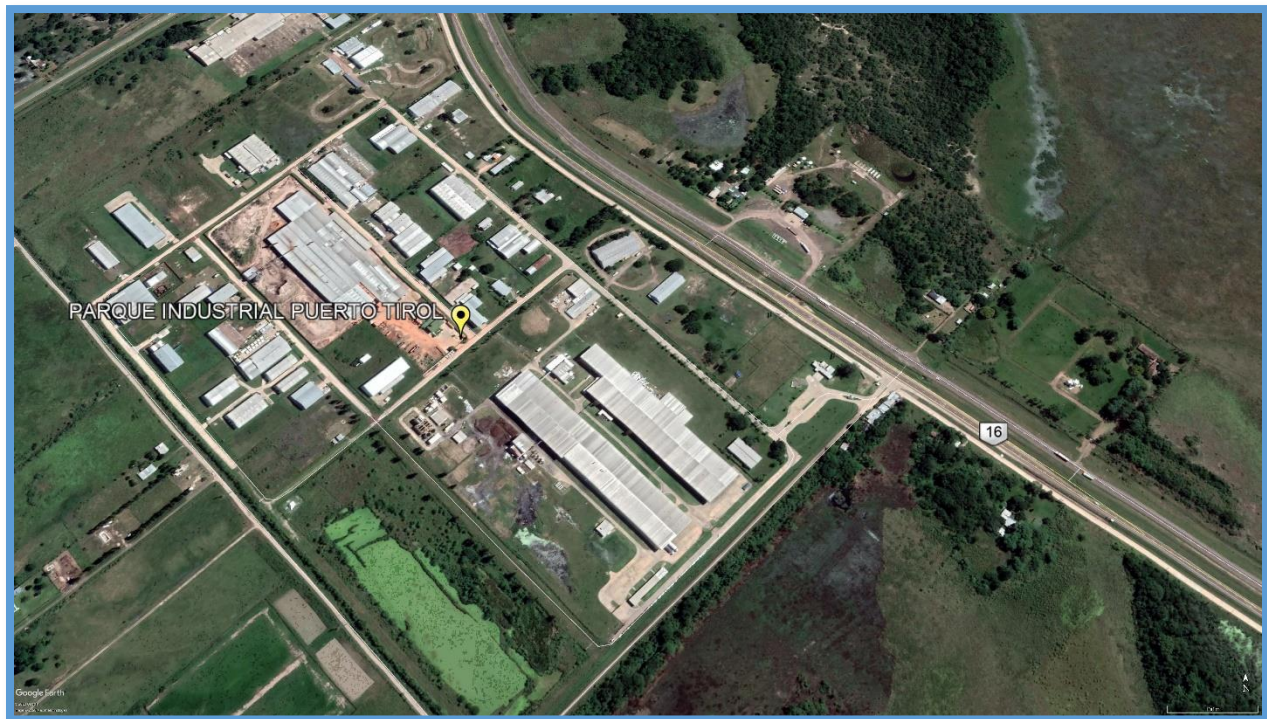
Figura 1: Ubicación Parque Industrial Puerto Tirol R.N. 16 km 24
