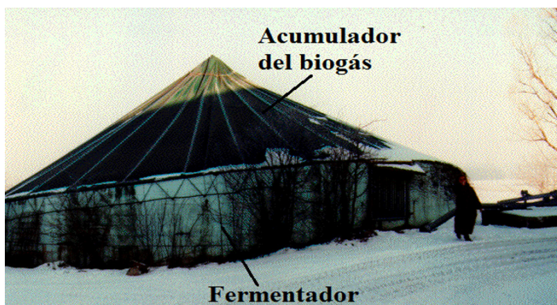
Figura 2.8. Biodigestor instalado en Freising, Alemania (Noemí Sogari).
