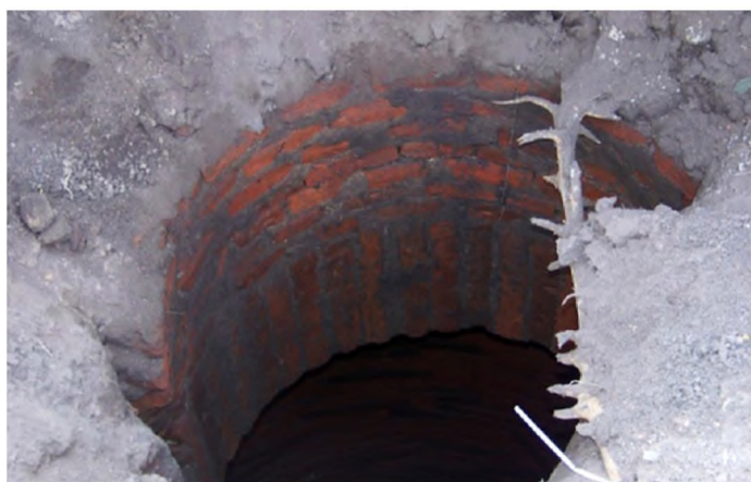
Foto 23. Imagen hacia el interior del pozo. Fuente: relevamiento Lic. Belén Aguirre.
