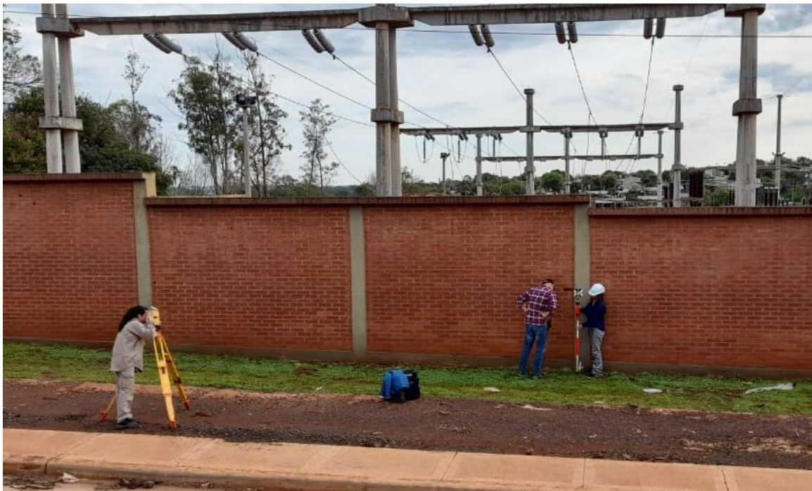
Fotografía N° 34 – “Balizamiento del punto fijo PF-PLA 02 – Estación Transformadora.” – Fuente: Propia.
