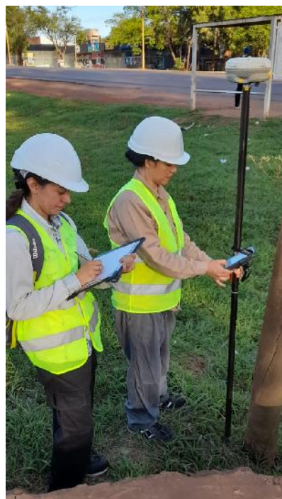
Fotografía N°21 y 22 - Toma de perfiles transversales al eje longitudinal de la obra.- Fuente: Propia.
