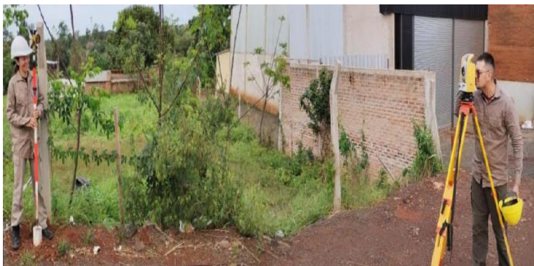
Fotografía N° 33 – “Balizamiento del punto fijo PF-PLA 01 – Diario “El Territorio.” – Fuente: Propia
