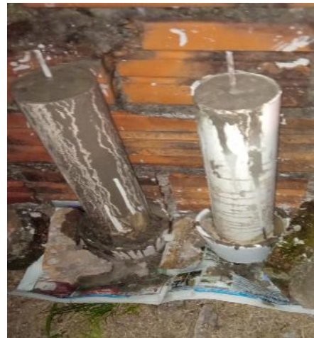
Fotografía N°13: Const. del mojón de hormigón - Fuente: Propia
