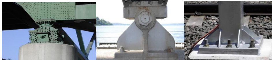
Figura a. Apoyo simple Figura b. Apoyo fijo Figura c. Empotramiento
