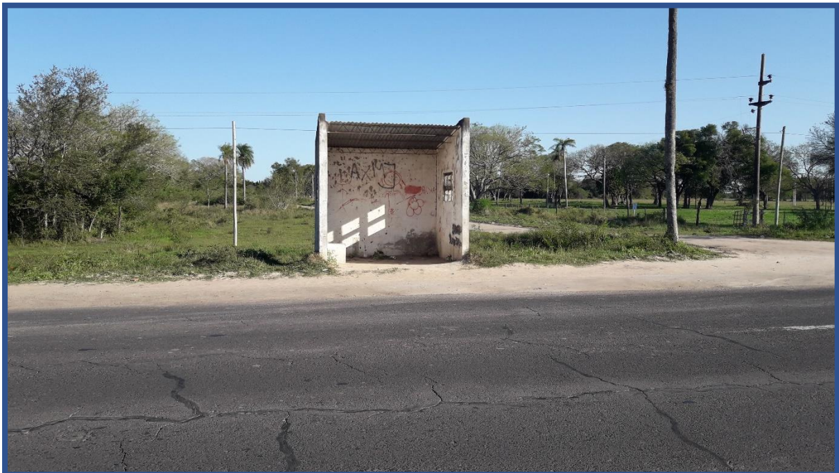
Imagen 6: Garita de mampostería.
