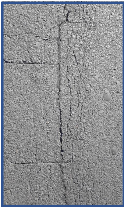
Imagen 3: Fisura longitudinal.
