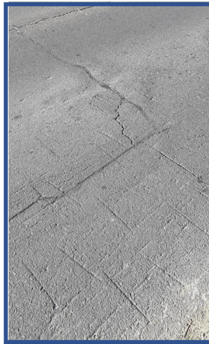
Imagen 4: Fisuración transversal.
