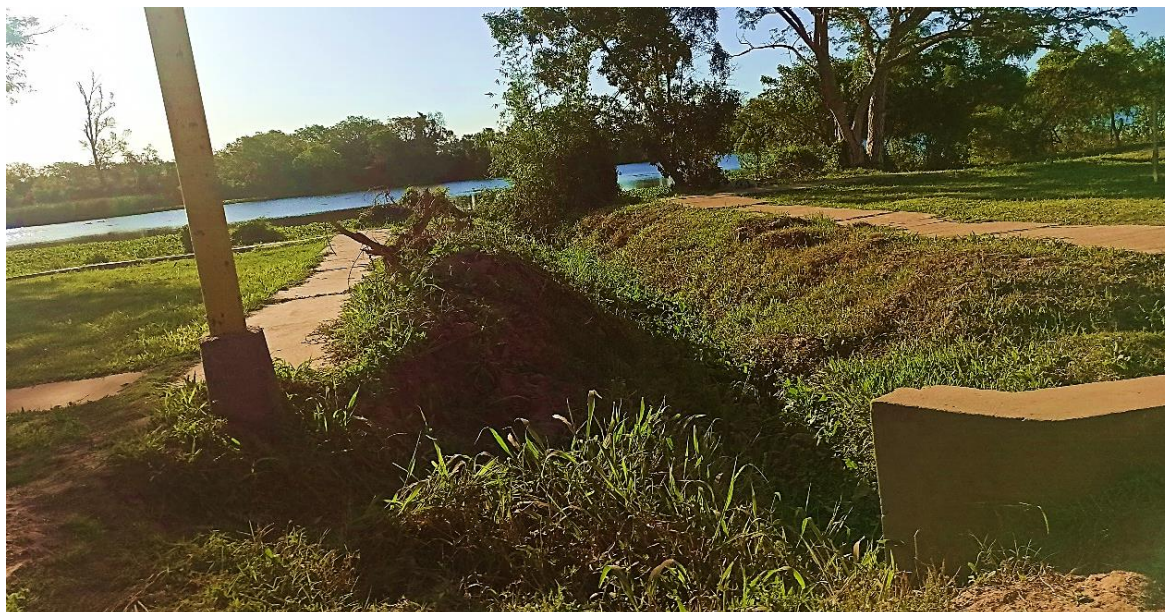
Fig. 72. Canal sin revestimiento para descarga sobre laguna Mujeres Argentinas (Fuente: Elaboración propia)
