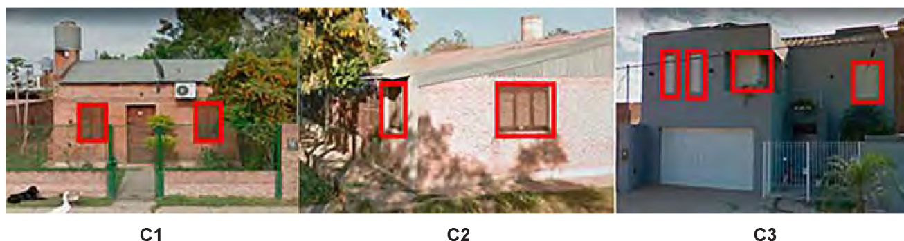
Figura 6. Fotos ilustrativas de las áreas vidriadas de las viviendas de los conglomerados protegidas por postigos con celosías (C1 y C2) y persianas (C3)
