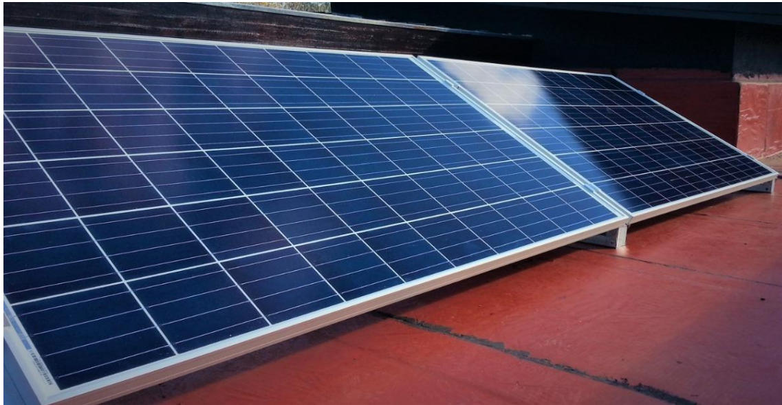
. Paneles Luxen 270W instalados. Fuente: MercadoLibre
