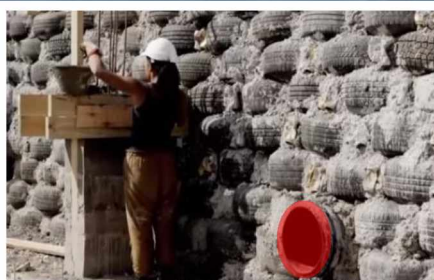
Tubos de ventilación que atraviesan el terraplén.
