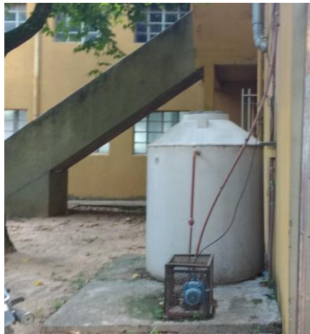
Cisterna de agua potable al pie Tanque elevado
