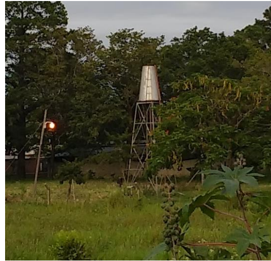
Tanque elevado existente en cercanía de Pollos
