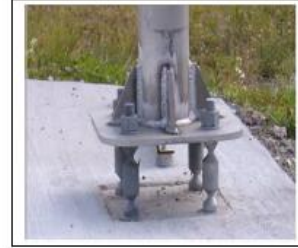
EJEMPLO DE BASE DE POSTE COLAPSABLE CERTIFICADO
