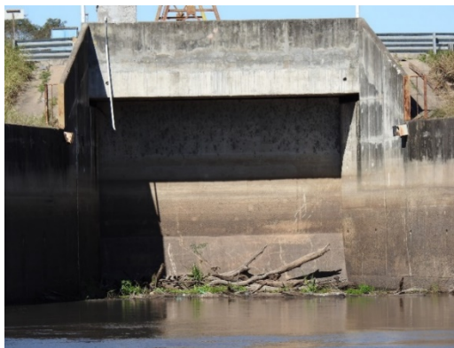
Figura 2: compuertas parcialmente abiertas (agosto 2019).
