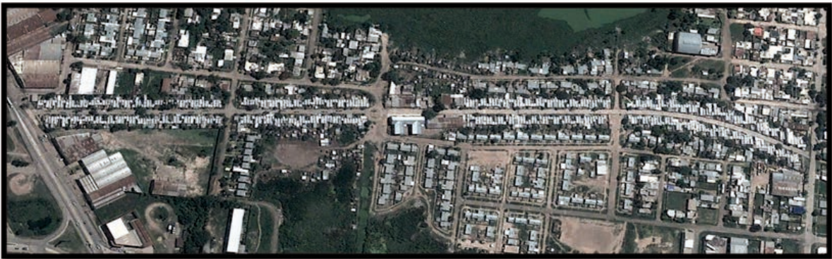
El barrio original fue construido con infraestructura de energía eléctrica y agua, pero los asentamientos posteriores, de ocupación irregular, carecieron inicialmente de estos servicios. Luego, con la regularización de la tenencia, se logró la construcción de las viviendas y la provisión de estas infraestructuras básicas.
