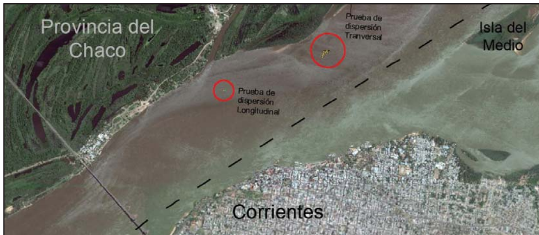
Figura 1.- Ubicación del Ensayo de campo.
