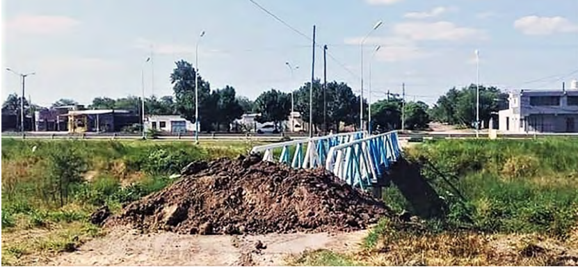
Figura 4. Cierre de puente en Av. Nicaragua y José María Paz, zona sur de Resistencia. Fuente: Infoqom, 2020 ( http://infoqom.com/cierran-puentes-y-pasarelas-que-conectan-con-la-zona-sur-de-resistencia/ )
