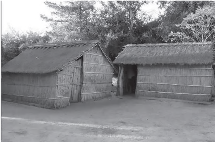
Figura 8. Vivienda estereña. Este tipo de construcción que se está perdiendo nos hace ver cómo sería la construcción en la que habitaron los primeros habitantes de estas regiones. Realizadas tanto en paredes como cubierta con fibra de "espartillo"
