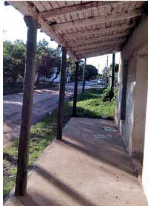
Figura 8. Vivienda estereña. Este tipo de construcción que se está perdiendo nos hace ver cómo sería la construcción en la que habitaron los primeros habitantes de estas regiones. Realizadas tanto en paredes como cubierta con fibra de "espartillo"
