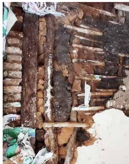
Figura 18. Arquitectura de tierra en Caa Cati: Técnica de estanco. Foto: Rosa, S. y Piñeiro, E. (2017). Foto: colección CEHAU
