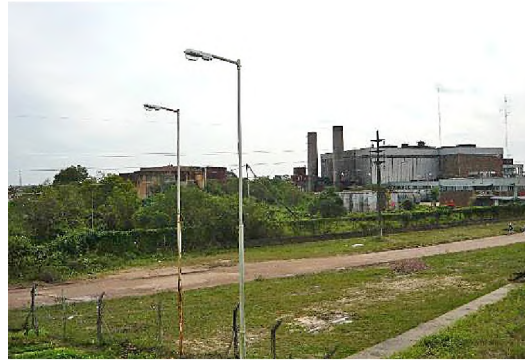
5. Usina eléctrica y área ferroviaria
